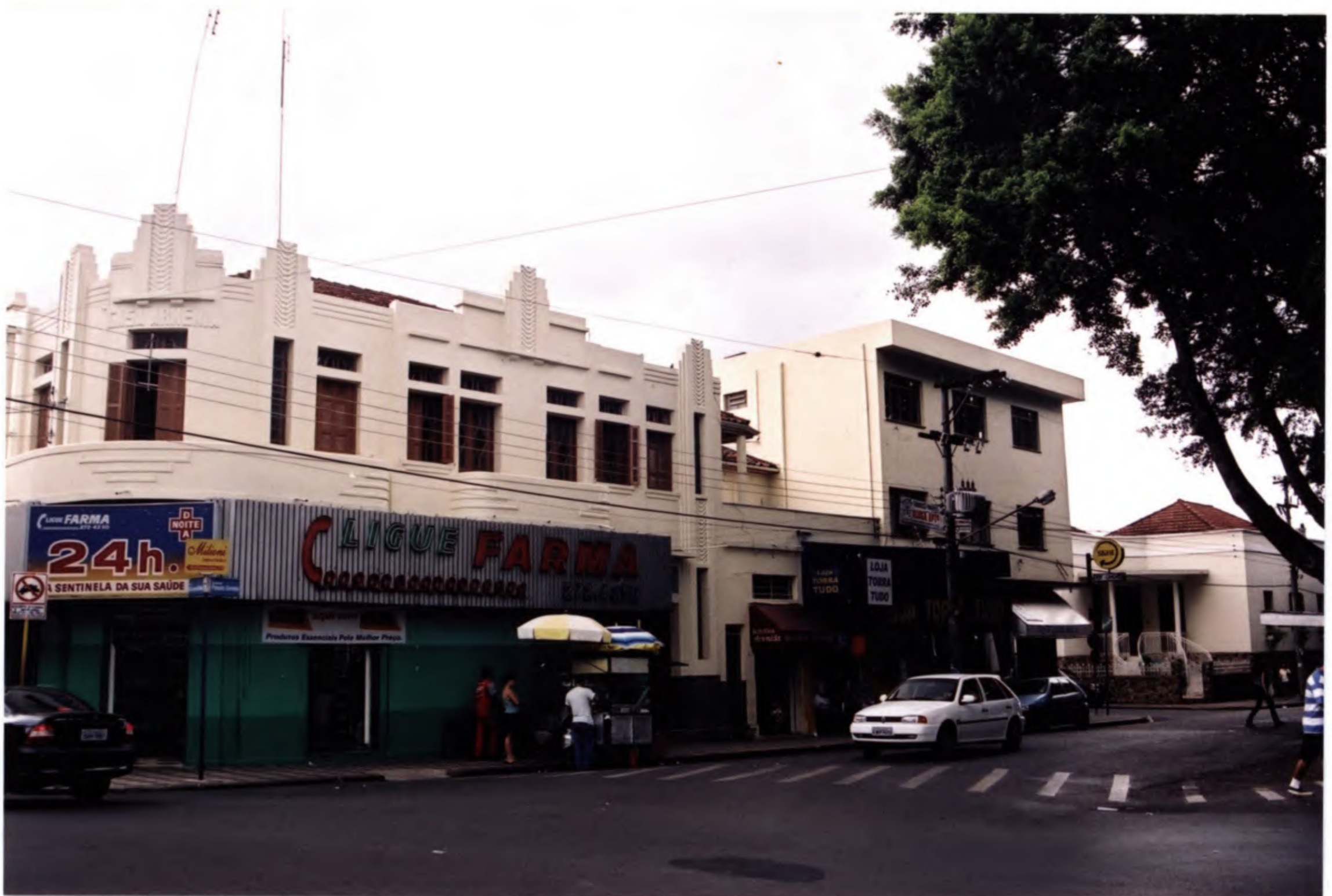
FOTO 24 - AV. PEIXOTO GOMIDE COM RUA CAMPOS SALLES
