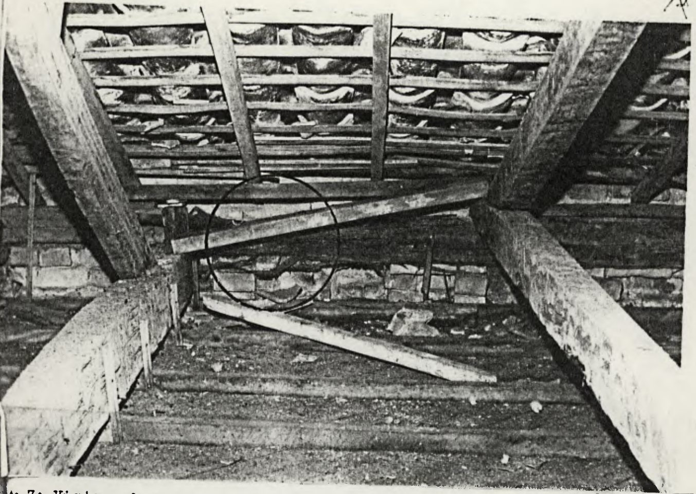
Fig. 7: Vista sob o telhado do prédio nº 151, mostrando também descontinuidade da madeira do flechal (detalhe no círculo) devido apodrecimento e peças soltas.
