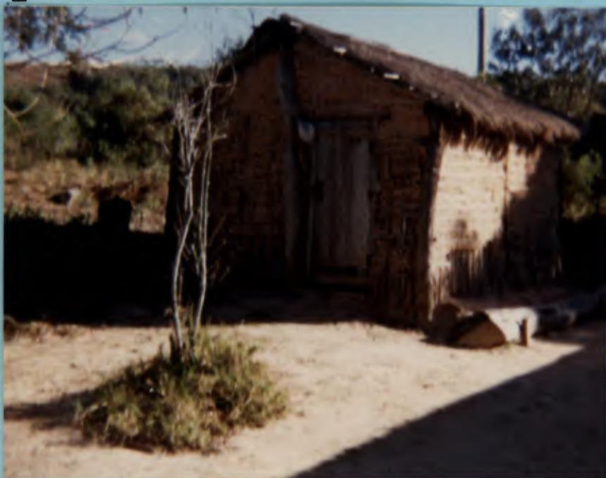
Casa de sapê na construção de Pau a Pique. Relíquia escrava. Aproximadamente com 80 anos de existência.
