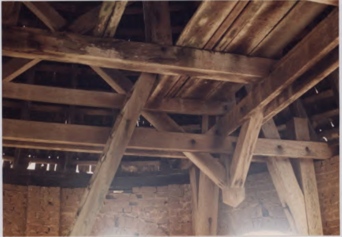
estrutura da cobertura
