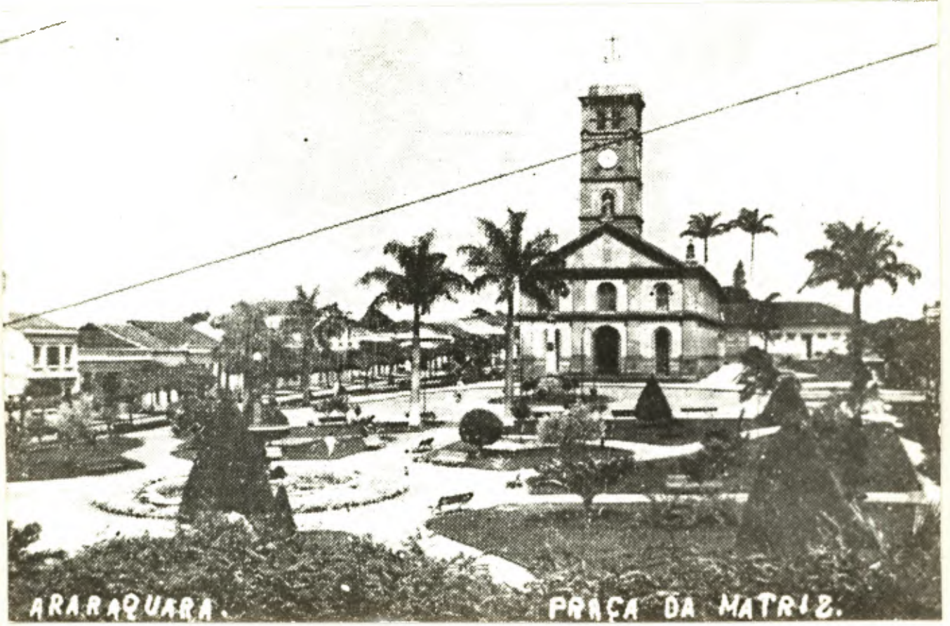
LARGO DA MATRIZ (DEMOLIDA)
