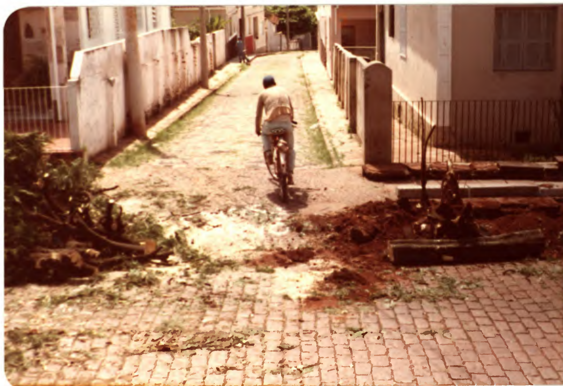
RUA O (CARVALHO FILHO), OBRAS DO ALARGAMENTO
