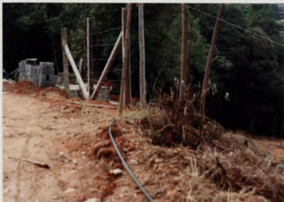
REALIZAÇÃO DE ATERRO E CONSTRUÇÃO NO LOTE À RUA OLÍPIO LEME S/Nº
