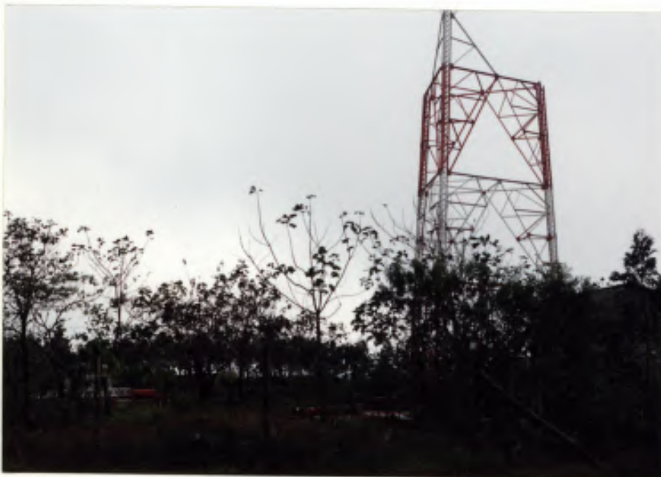
→ TORRE SEMI CONSTRUÍ DA EM TERRENO EM TOPO DE MORRO
