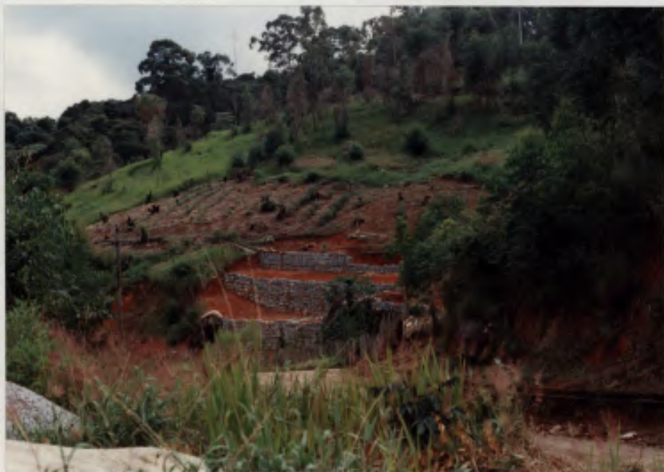
MOVIMENTO DE TERRA COM FORMAÇÃO DE PATAMA- RES PARA FUTURO PLANTIO.
