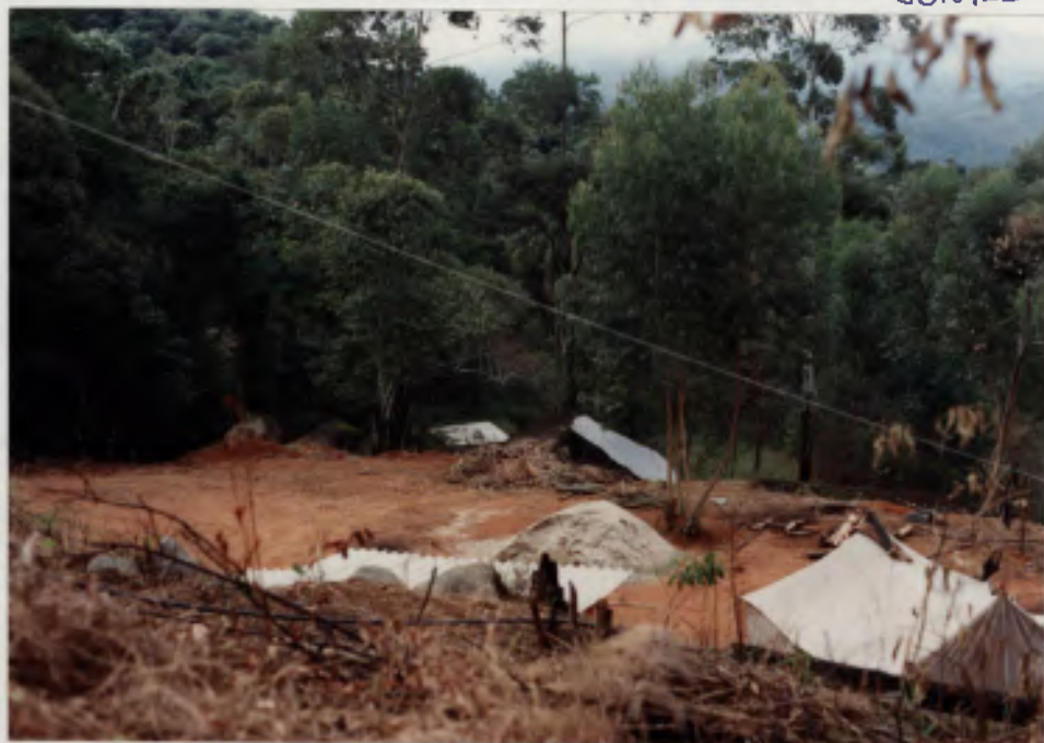
LOTTE DE MATAÇÃO E REALIZAÇÃO DE ATERRO LOTE NO CAP. RICARDO NOGUEIRA DE UMA
