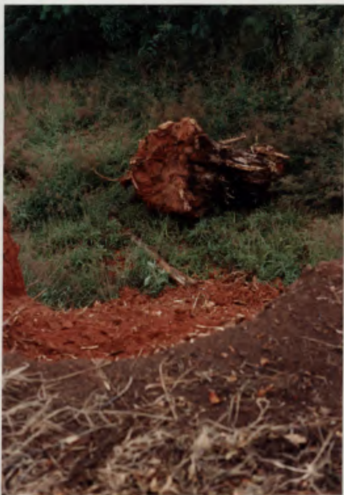
DESTOCAMENTO DE TERRENO
