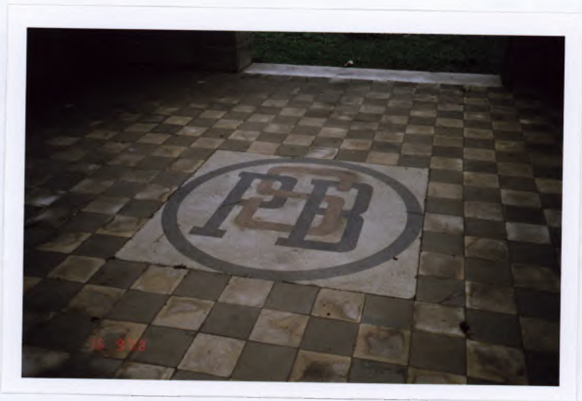
PISO DO PAULHÃO CENTRAL DA PÉRGOLA
