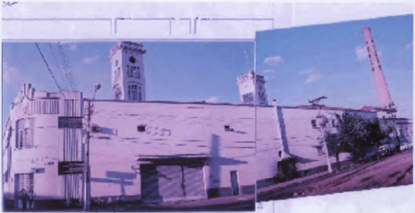
Vista geral do escritório, garagem, cruz e chaminé.
