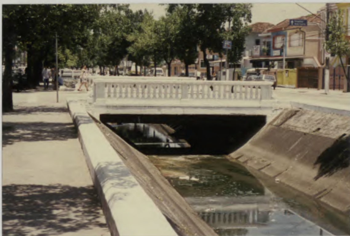
Ponte sobre o canal nº 2 Av. Bernardino de Campos
