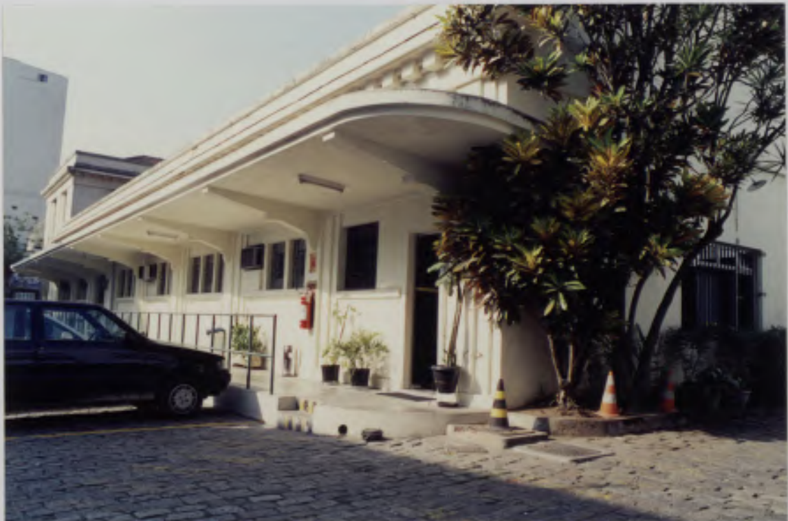
MARQUISE LATERAL DO EDIFÍCIO DO ALMOXARIFADO
