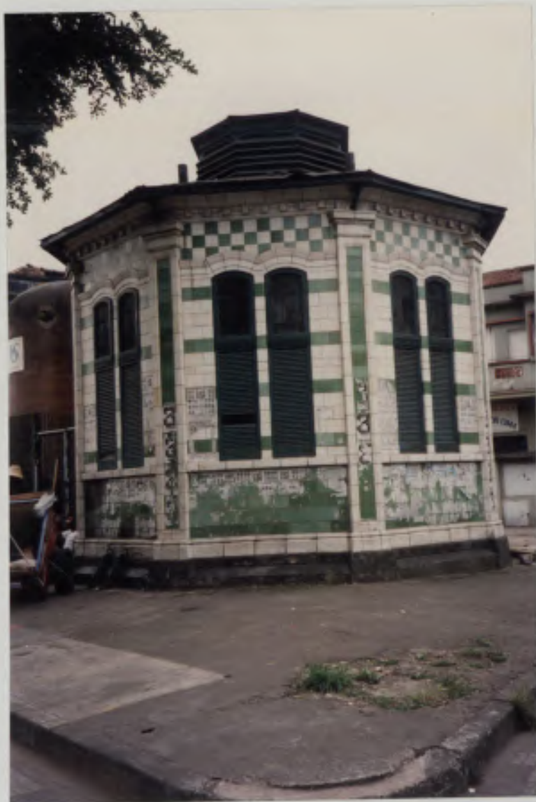
Quiosque - Latrina Estação Elevatória de Esgoto nº IV Av. Conselheiro Nébias
