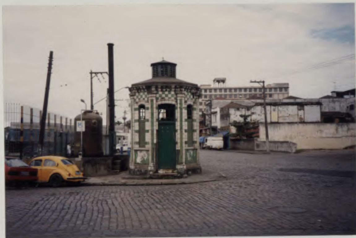
Quiosque - Latrina Estação Elevatória de Esgoto nº III R. João Otávio
