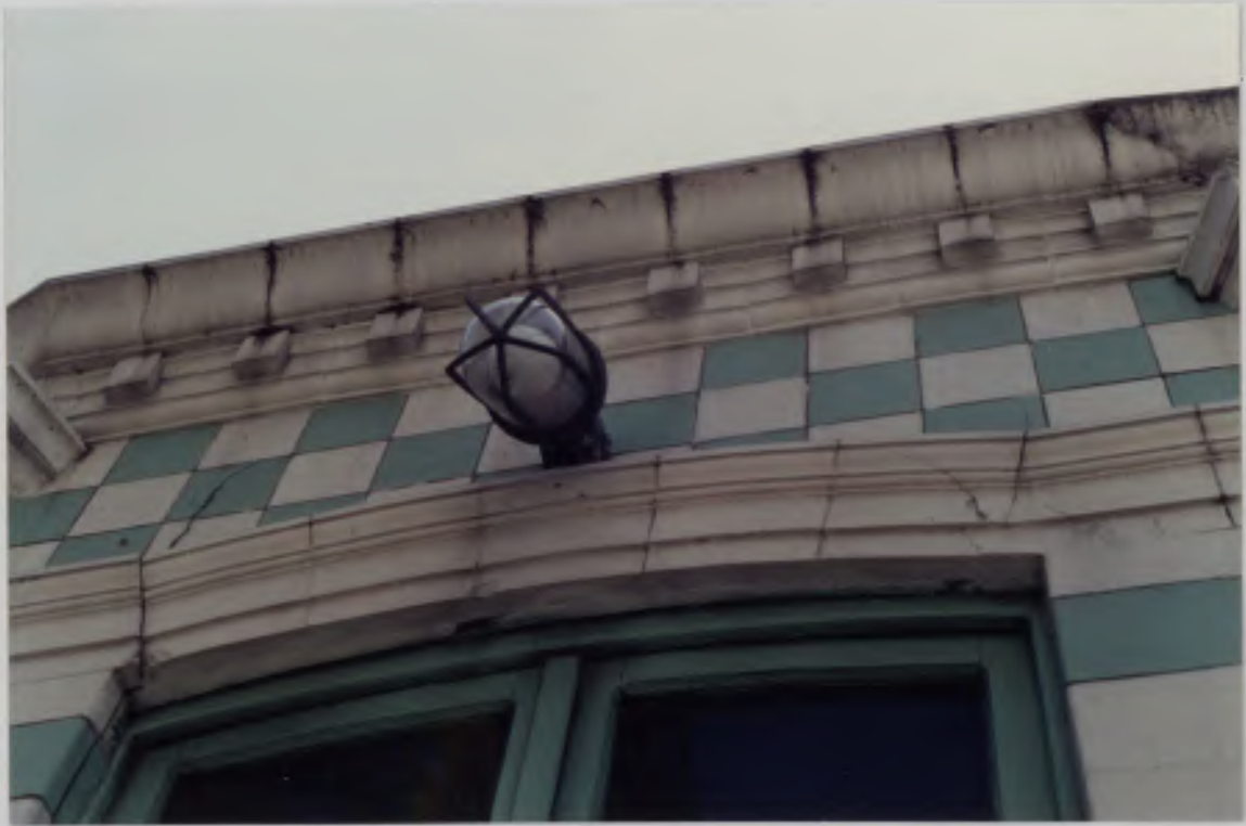
ESTAÇÃO ELEVATORIA DISTRITAL DE SÃO VICENTE ( TOMÉ DE SOUZA )
