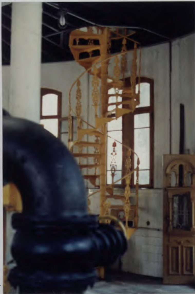
INTERIOR DA ESTAÇÃO ELEVATORIA CENTRAL
