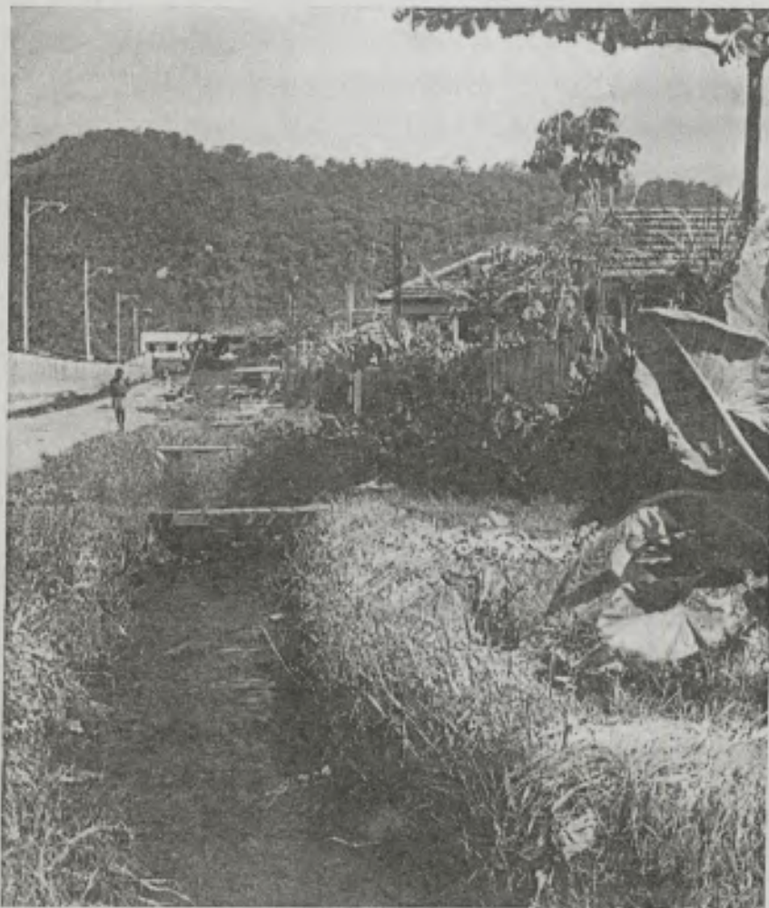
Outro aspecto do mesmo bairro, onde se ressalta uma vala a céu-aberto, à guisa de canalização das águas pluviais.
