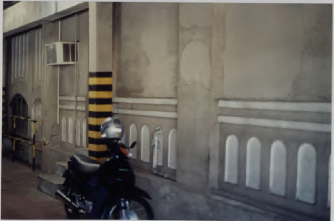
FACHADA LATERAL DIREITA
