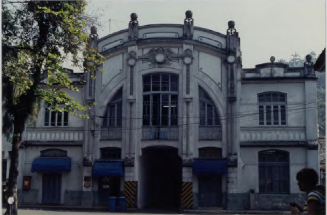
FACHADA PRINCIPAL DA USINA DE PREVENÇÃO
