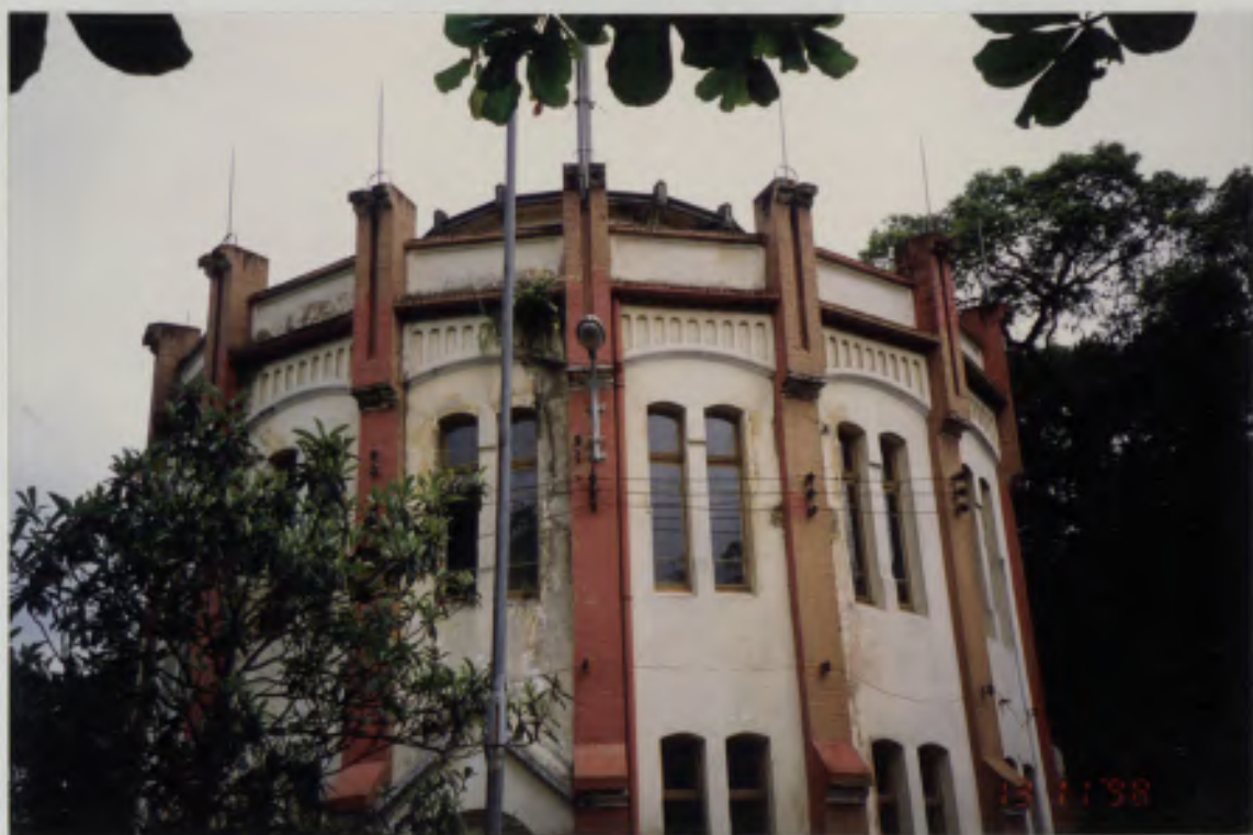
Estação Elevatória de Esgoto - Central José Menino
