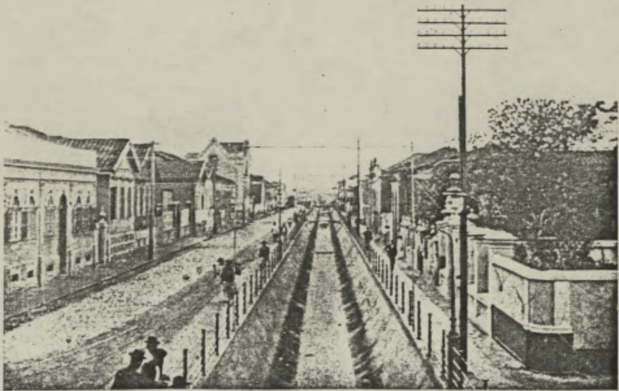
SANEAMENTO DE SANTOS : Canal — Trecho na R. Rangel Pestana (concreto armado)
