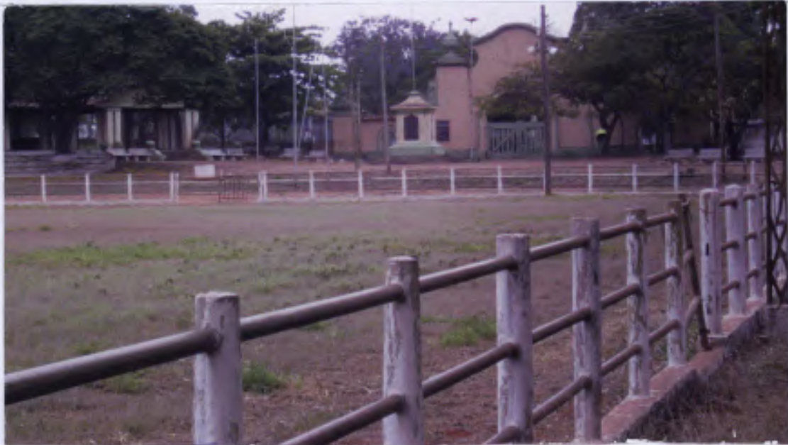
Portal de Acesso, vista da arena.
