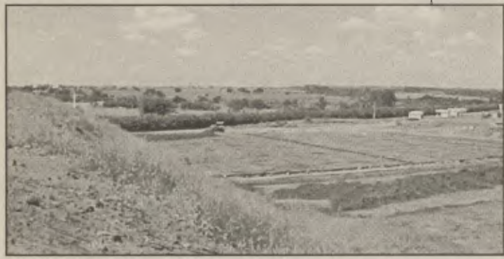
Vista parcial do aterro sanitário do município de Mirassol
