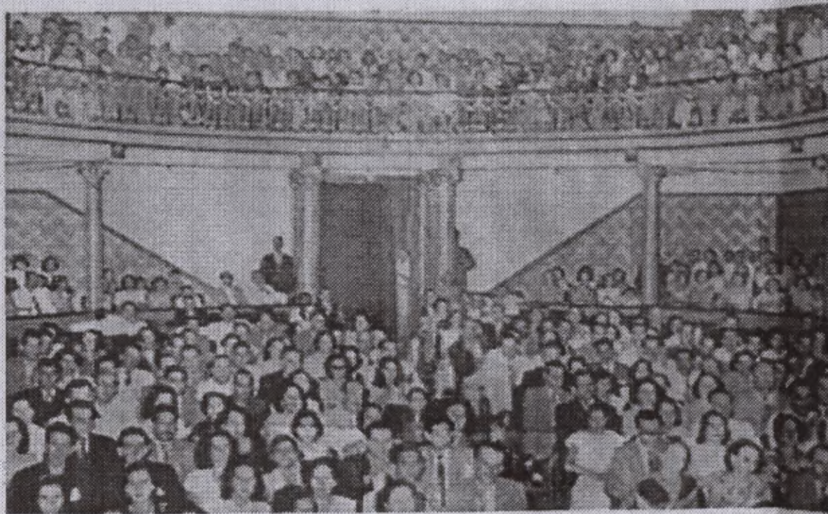
Vista interna do prédio, em 1954, com frisas e camarotes
