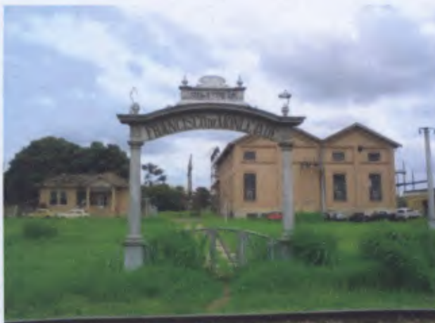
Pórtico (Art. 1º, IX) de acesso à Subestação Elétrica (Art. 1º, V) e Vila de Engenheiros (Art. 1º, VI)
