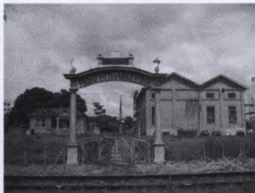
Vista Geral da subestação, 05/02/2009.
