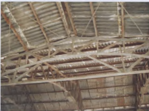
Detalhe do interior: cobertura da gare (Art. 1º, I)
