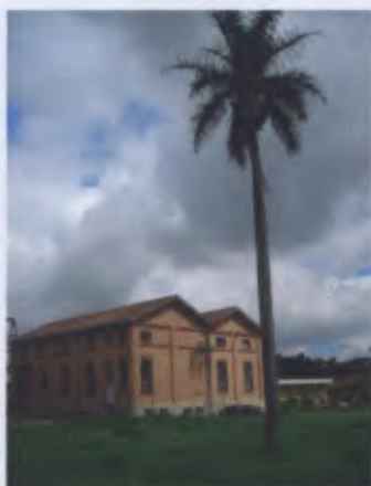
Subestação (Art. 1º, V)
