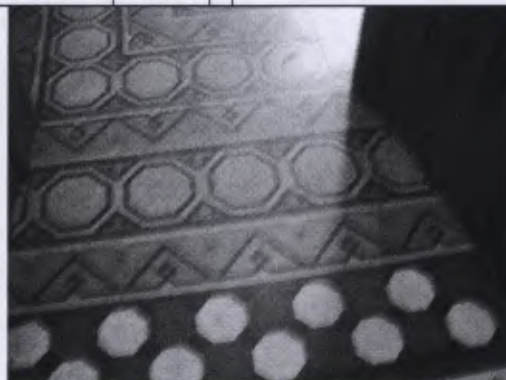
Piso de ladrilho hidráulico, 05/02/2009.
