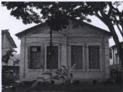
Fachada principal das casas, 05/02/2009.
