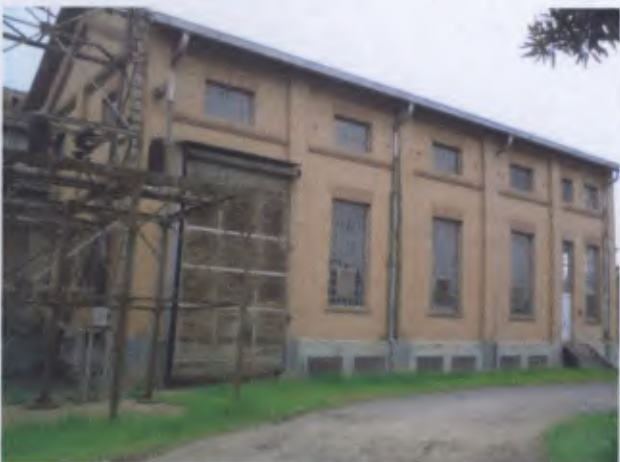
Subestação Elétrica (Art. 1º, V)
