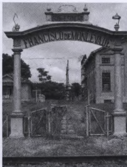
Portal da Subestação, 05/02/2009
