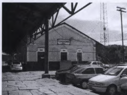
Elevação Principal da Estação, 05/02/2009.
