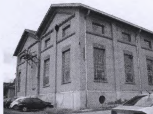
Prédio da Subestação, 05/02/2009.
