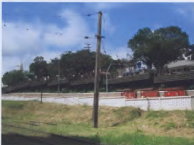
Entorno da estação: patamares para contemplanção da área
