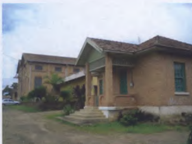
Vila de Engenheiros (Art. 1º, VI) e, ao fundo, Subestação Elétrica (Art. 1º, V)
