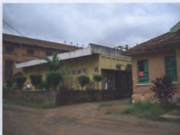
Edifício destoante no interior do perímetro de tombamento
