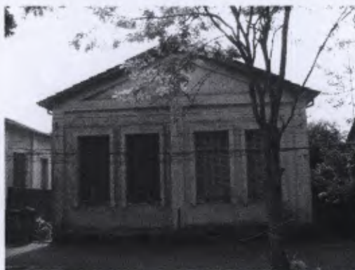
Fachada principal das casas, 05/02/2009.
