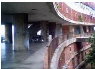
Conjunto de Pedregulho, Afonso Reidy. Foto de 2006 Foto Helga Santos da Silva
