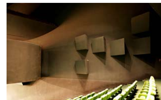
Painel acústico em concreto, Sala Villa-Lobos, Teatro Nacional Cláudio Santoro, 1978
