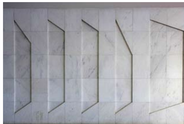
Painel em mármore, Palácio do Itamaraty, 1966 (detalhe)
