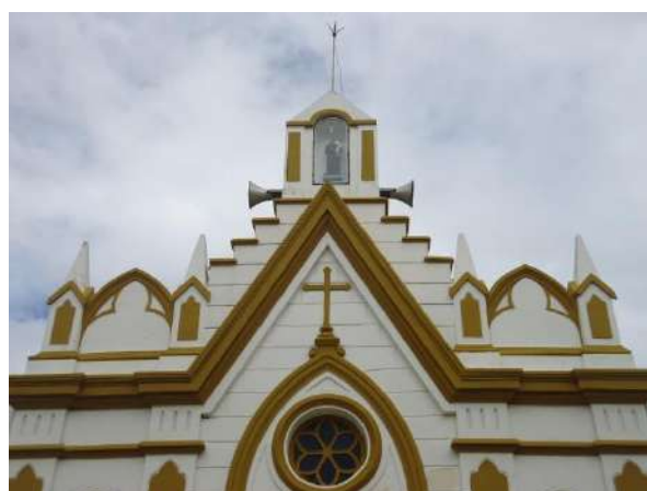
Pará de Minas Núcleo Histórico Urbano do Distrito de Ascensão Detalhes do pórtico e dos altos e baixos relevos, bem conservados. (foto 46)
