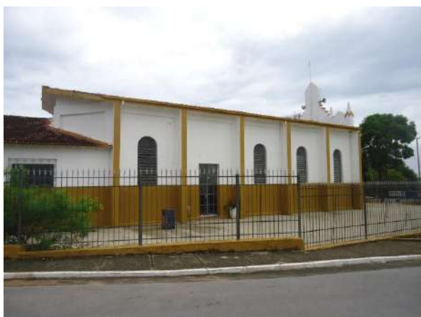
Pará de Minas Núcleo Histórico Urbano do Distrito de Ascensão Vista da fachada lateral direita da Igreja, exibe bom estado de conservação. (foto 41)
