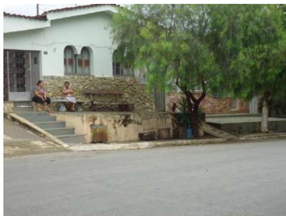
Pará de Minas Núcleo Histórico Urbano do Distrito de Ascensão Calçadas de diferentes materiais e níveis que impedem a acessibilidade na via Praça Santo Antônio. (Foto 26)
