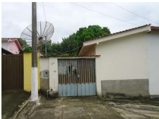
Pará de Minas Núcleo Histórico Urbano do Distrito de Ascensão Edificação à Rua Pompéu, 038.
