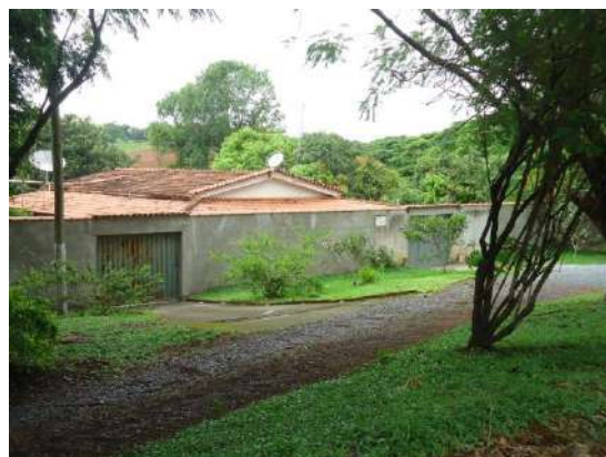
Pará de Minas Núcleo Histórico Urbano do Distrito de Ascensão Edificação à Avenida Presidente Kubitschek, 301. (foto 74)
