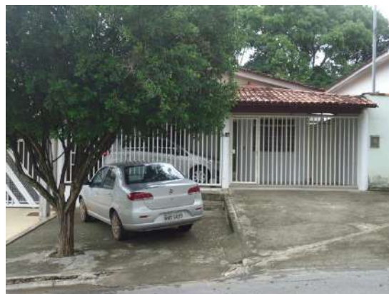
Pará de Minas Núcleo Histórico Urbano do Distrito de Ascensão Edificação à Avenida Abdon Senem de Araújo, 040. (foto 48)
