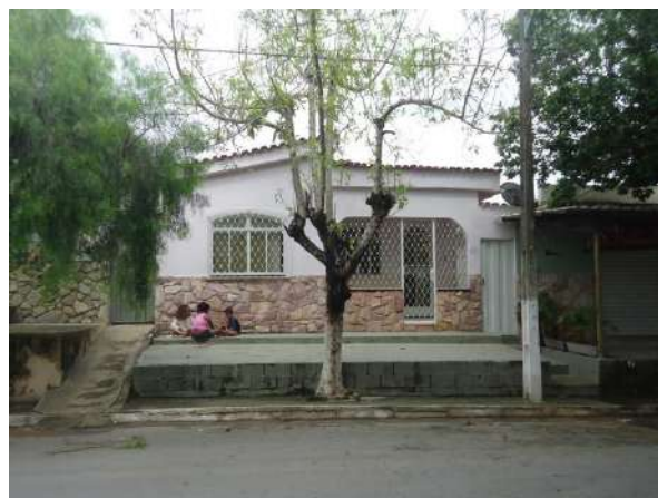
Pará de Minas Núcleo Histórico Urbano do Distrito de Ascensão Calçada na via Praça Santo Antônio em bom estado de conservação mas sem acessibilidade. (Foto 20)
