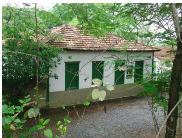
Pará de Minas Núcleo Histórico Urbano do Distrito de Ascensão Exemplar bem conservado da arquitetura neocolonial que caracteriza o distrito. (Foto 37) Imagem: Álisson Margotti – 25/10/2018
