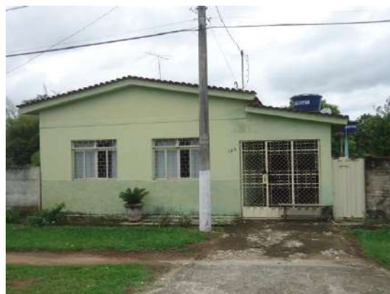
Pará de Minas Núcleo Histórico Urbano do Distrito de Ascensão Edificação à Rua Raimundo Penaforte, de Araújo, 126. (foto 98)
