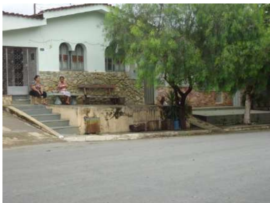
Pará de Minas Núcleo Histórico Urbano do Distrito de Ascensão Edificação à Praça Santo Antônio, 121. (foto 83)
