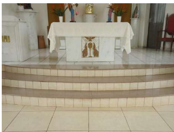
Pará de Minas Núcleo Histórico Urbano do Distrito de Ascensão Detalhe piso do altar e do púlpito em mármore, bem conservados. (foto 45)
