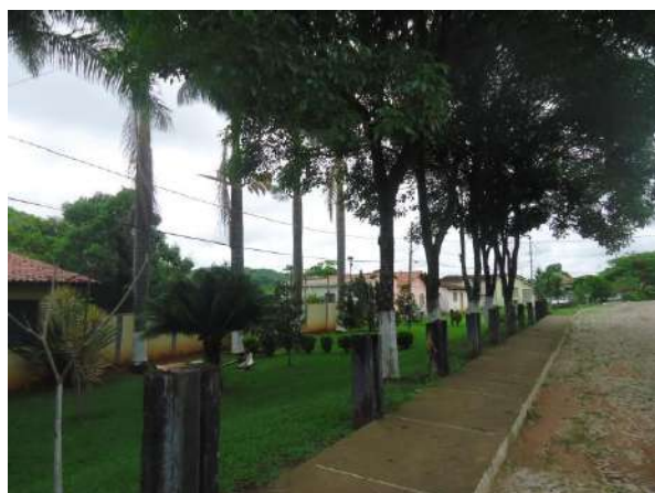
Pará de Minas Núcleo Histórico Urbano do Distrito de Ascensão A Rua Raimundo Penaforte de Araújo não exhibe sarjetas nem bocas de lobo.
