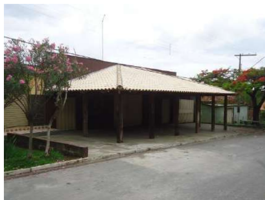
Pará de Minas Núcleo Histórico Urbano do Distrito de Ascensão Edificação à Avenida Abdon Senem de Araújo, SN. (foto 58)
