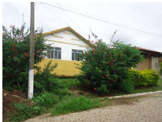
Pará de Minas Núcleo Histórico Urbano do Distrito de Ascensão Edificação à Avenida Presidente Kubitschek, 110. (foto 66)
