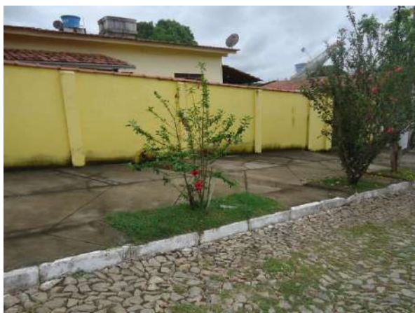
Pará de Minas Núcleo Histórico Urbano do Distrito de Ascensão Calçada em bom estado de conservação e sem acessibilidade na Rua Pompéu. (Foto 19)
