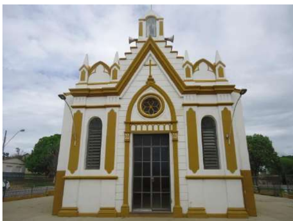
Pará de Minas Núcleo Histórico Urbano do Distrito de Ascensão Vista frontal da Igreja de Santo Antônio, bem conservada. (foto 39)
