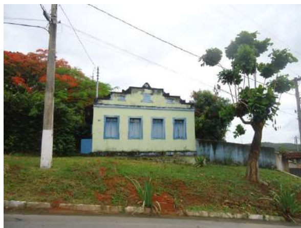
Pará de Minas Núcleo Histórico Urbano do Distrito de Ascensão Fiação aparente em todo o Núcleo Histórico, detalhe da Avenida Presidente Kubitschek. (Foto 35) Imagem: Álisson Margotti – 25/10/2018
