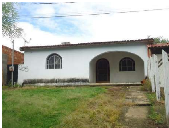
Pará de Minas Núcleo Histórico Urbano do Distrito de Ascensão Edificação típica dos anos 1980, na Avenida Raimundo Penaforte de Oliveira. (Foto 38)
