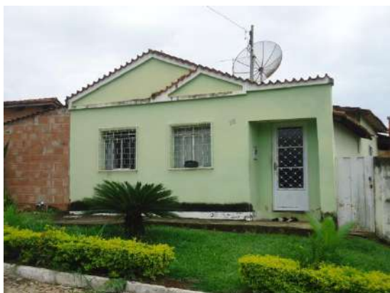
Pará de Minas Núcleo Histórico Urbano do Distrito de Ascensão Edificação à Rua Nova Serrana, 016. (foto 87)
