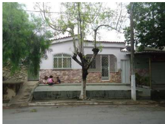
Pará de Minas Núcleo Histórico Urbano do Distrito de Ascensão Edificação à Praça Santo Antônio, 129. (foto 84)
