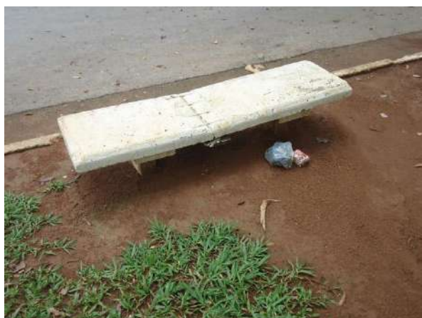
Pará de Minas Núcleo Histórico Urbano do Distrito de Ascensão Bancos em concreto em bom estado de conservação na Praça Santo Antônio.
