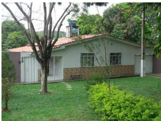
Pará de Minas Núcleo Histórico Urbano do Distrito de Ascensão Edificação à Rua Raimundo Penaforte, de Araújo, 020.
