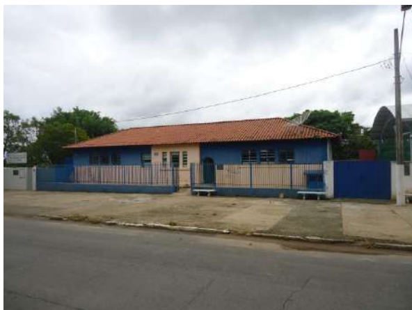
Pará de Minas Núcleo Histórico Urbano do Distrito de Ascensão Calçada em concreto na Praça Santo Antônio exibindo sujidades e fissuras. (Foto 23)
