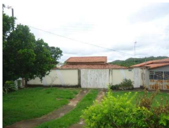
Pará de Minas Núcleo Histórico Urbano do Distrito de Ascensão Edificação à Rua Raimundo Penaforte, de Araújo, 040.
