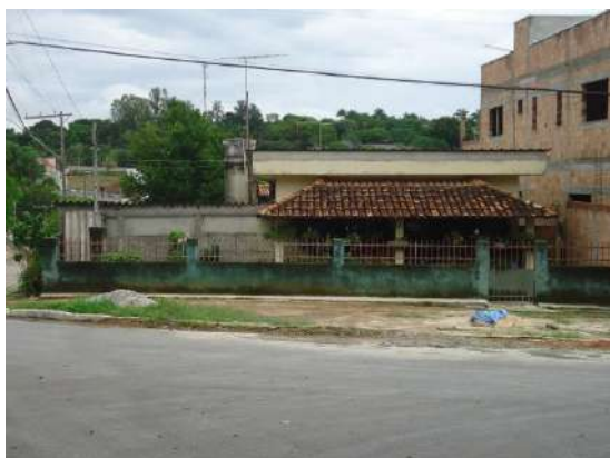
Pará de Minas Núcleo Histórico Urbano do Distrito de Ascensão Edificação à Avenida Abdon Senem de Araújo, 160. (foto 57)
