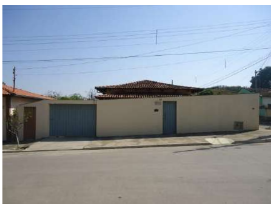
Pará de Minas Núcleo Histórico Urbano do Distrito de Carioca Praça Nossa Senhora de Lourdes, 81 (foto 55) Imagem: Álisson Margotti – 13/09/2018
