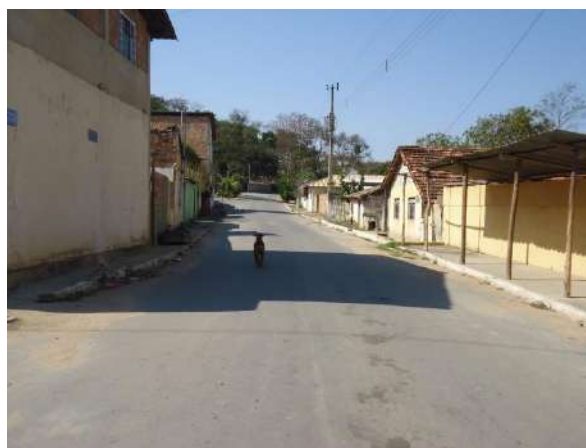
Pará de Minas Núcleo Histórico Urbano do Distrito de Carioca Vista da via Dona Maria Lopes Cançado, em bom estado mas exibindo acúmulo de sujidades. (foto 03) Imagem: Álisson Margotti – 13/09/2018
