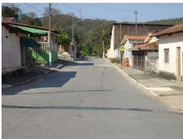
Pará de Minas Núcleo Histórico Urbano do Distrito de Carioca Vista da via Nossa Senhora da Piedade, com pavimentação asfáltica em bom estado. (foto 02) Imagem: Álisson Margotti – 13/09/2018
