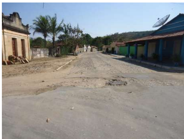
Pará de Minas Núcleo Histórico Urbano do Distrito de Carioca Calçada em terra compactada na Rua São Francisco. (foto 25)
