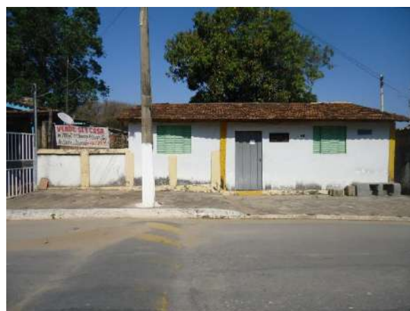
Pará de Minas Núcleo Histórico Urbano do Distrito de Carioca Bancos encostados nas edificações na Rua São Francisco. (foto 27)
