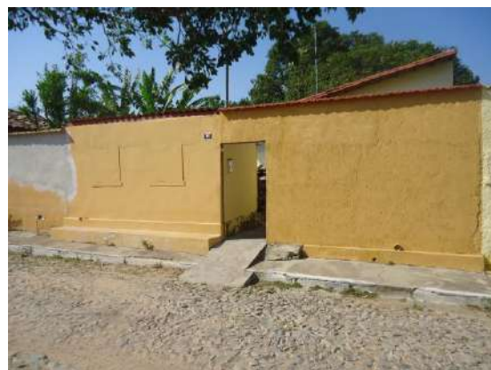
Pará de Minas Núcleo Histórico Urbano do Distrito de Carioca Rua Dom Bosco, 95 (foto 62) Imagem: Álisson Margotti – 13/09/2018
