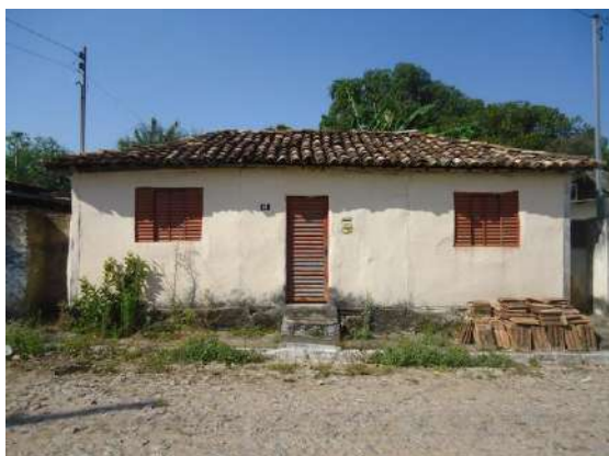
Pará de Minas Núcleo Histórico Urbano do Distrito de Carioca Rua Dom Bosco, 81 (foto 61) Imagem: Álisson Margotti – 13/09/2018
