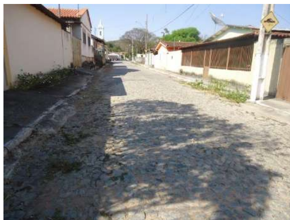
Pará de Minas Núcleo Histórico Urbano do Distrito de Carioca Aspecto de trecho da Rua Nossa Senhora da Piedade que não exibe vegetação na via. (foto 16)
