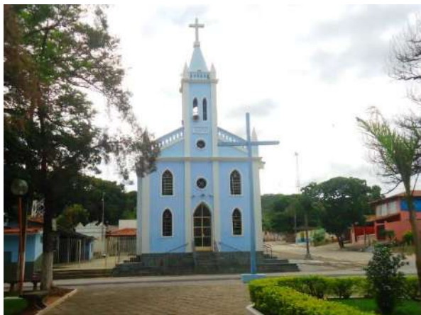
Pará de Minas Núcleo Histórico Urbano do Distrito de Carioca Vista da fachada frontal da Igreja de Nossa Senhora Lourdes, bem conservada. (foto 37)
