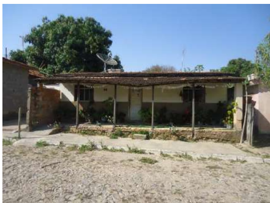
Pará de Minas Núcleo Histórico Urbano do Distrito de Carioca Rua Dom Bosco, 57 (foto 59) Imagem: Álisson Margotti – 13/09/2018
