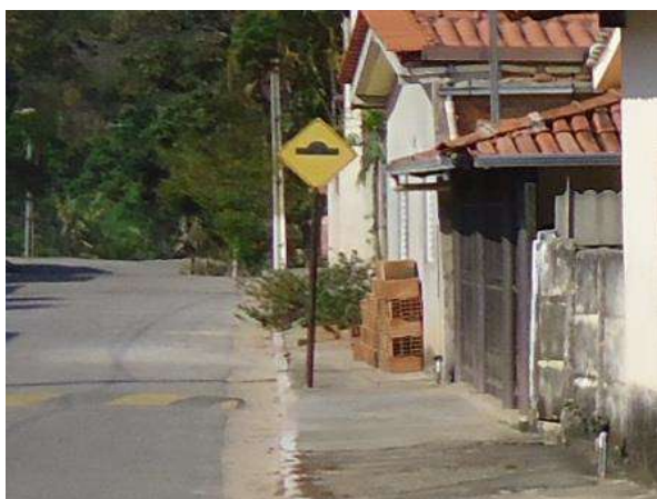
Pará de Minas Núcleo Histórico Urbano do Distrito de Carioca Placa de trânsito com alguma oxidação e desgaste da camada pictórica. (foto 08)
