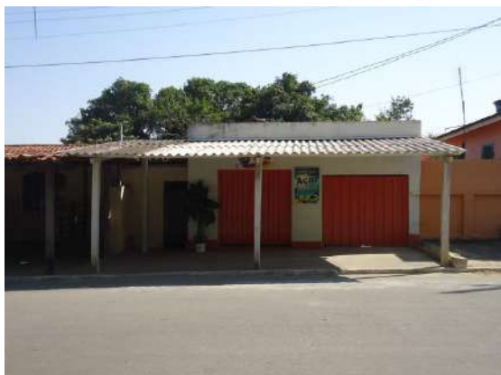
Pará de Minas Núcleo Histórico Urbano do Distrito de Carioca Praça Nossa Senhora de Lourdes, 41 (foto 51) Imagem: Álisson Margotti – 13/09/2018
