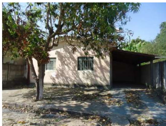
Pará de Minas Núcleo Histórico Urbano do Distrito de Carioca Rua Dom Bosco, 71 (foto 60) Imagem: Álisson Margotti – 13/09/2018
