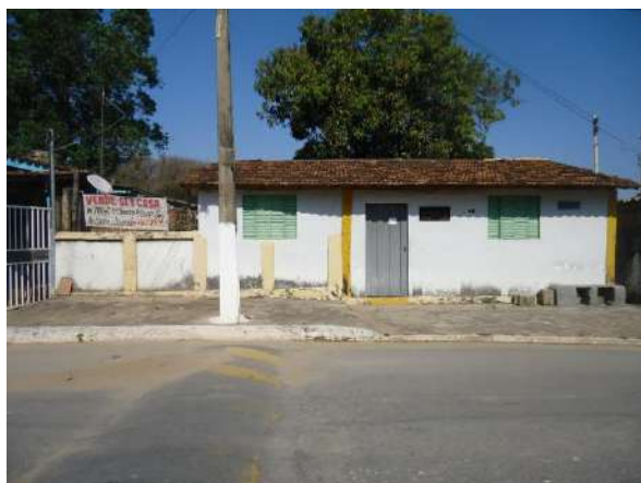
Pará de Minas Núcleo Histórico Urbano do Distrito de Carioca Fiação aparente e faixa na Rua São Francisco. (foto 32)
