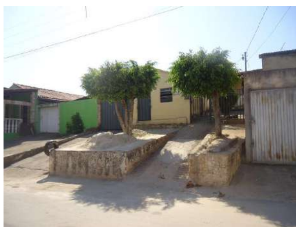
Pará de Minas Núcleo Histórico Urbano do Distrito de Carioca Degraus entres os diferentes níveis de uma calçada na Rua Nossa Senhora da Piedade.
