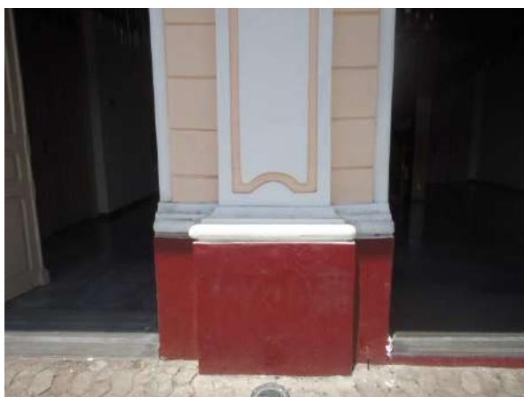
Pará de Minas Prédio Juscelino Kubitschek de Oliveira – Casa da Cultura A alvenaria externa da edificação se apresenta em bom estado de conservação.
