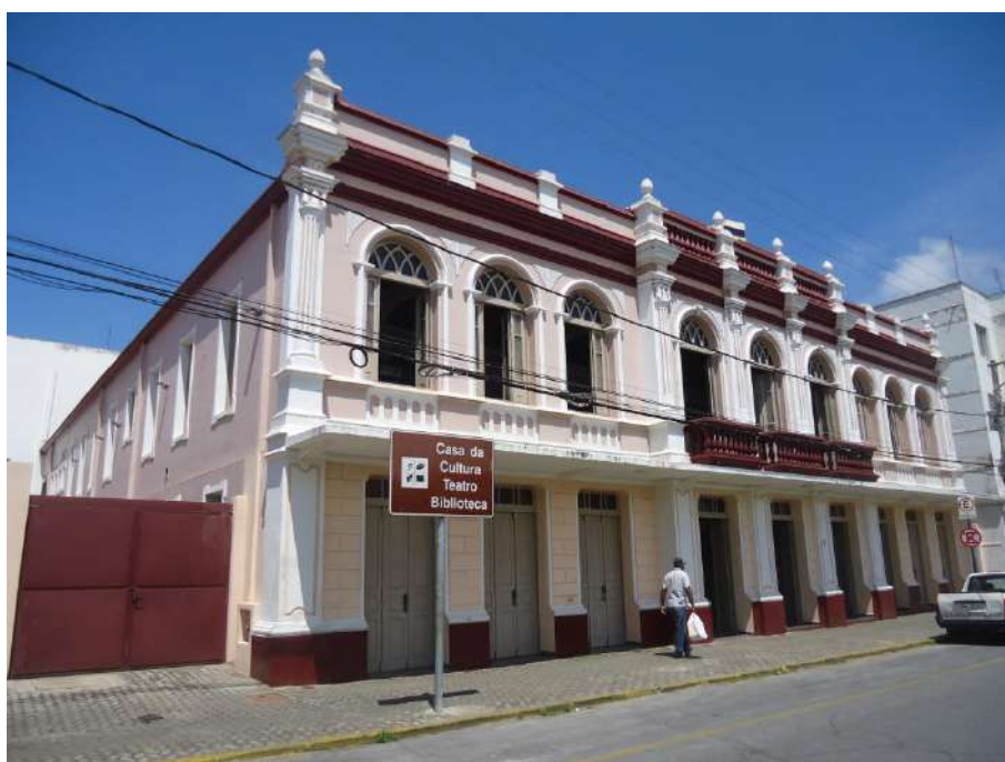
Pará de Minas Prédio Juscelino Kubitschek de Oliveira – Casa da Cultura Fachada Frontal da edificação. (Foto 01)
