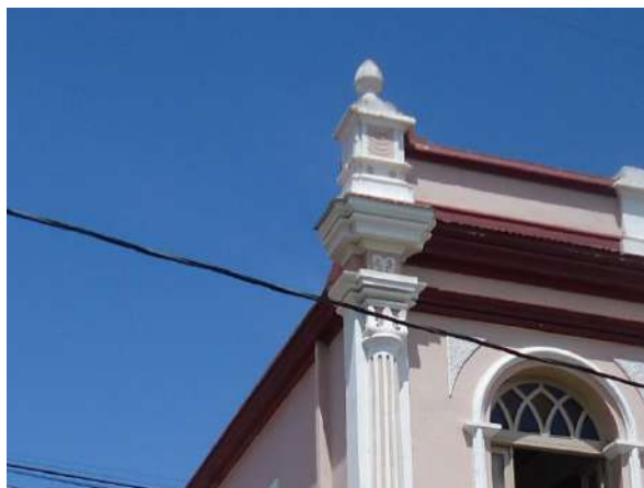
Pará de Minas Prédio Juscelino Kubitschek de Oliveira – Casa da Cultura Detalhe dos beirais, calhas e cimalkas em bom estado de conservação.
