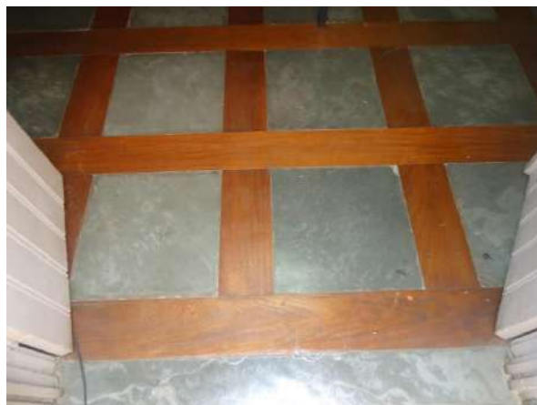
Pará de Minas Prédio Juscelino Kubitschek de Oliveira – Casa da Cultura Piso em ardósia e madeira em algumas salas do térreo com madeira melhor conservada que a ardósia. (Foto 48) Imagem: Álisson Margotti – 16/10/2018
