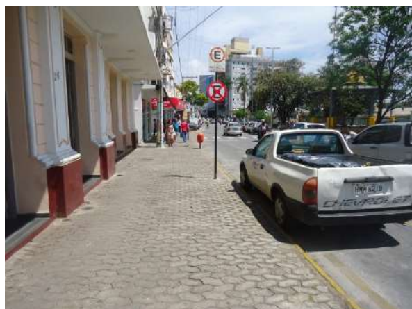
Pará de Minas Prédio Juscelino Kubitschek de Oliveira – Casa da Cultura Vista com sentido noroeste onde se observam edificações de até 15 pav. e trânsito intenso. (Foto 67) Imagem: Álisson Margotti – 16/10/2018
