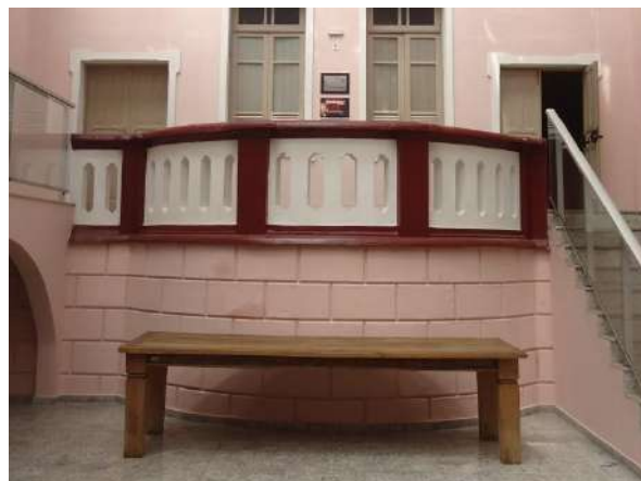
Pará de Minas Prédio Juscelino Kubitschek de Oliveira – Casa da Cultura Balaustre que perfaz o contorno do mezanino no átrio em bom estado de conservação. O mezanino está implantado há 1,78m acima do átrio e dá acesso ao Teatro Municipal.
