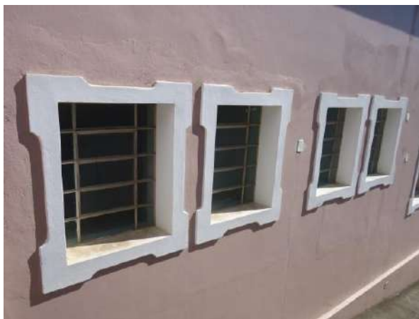
Pará de Minas Prédio Juscelino Kubitschek de Oliveira – Casa da Cultura Janelas do porão em vidro e basculantes em ferro, em bom estado de conservação. (Foto 35) Imagem: Álisson Margotti – 16/10/2018
