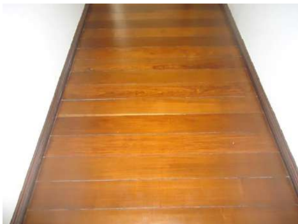
Pará de Minas Prédio Juscelino Kubitschek de Oliveira – Casa da Cultura O piso em madeira da biblioteca no 2º pavimento do bem se encontra bem conservado. (Foto 47) Imagem: Álisson Margotti – 16/10/2018
