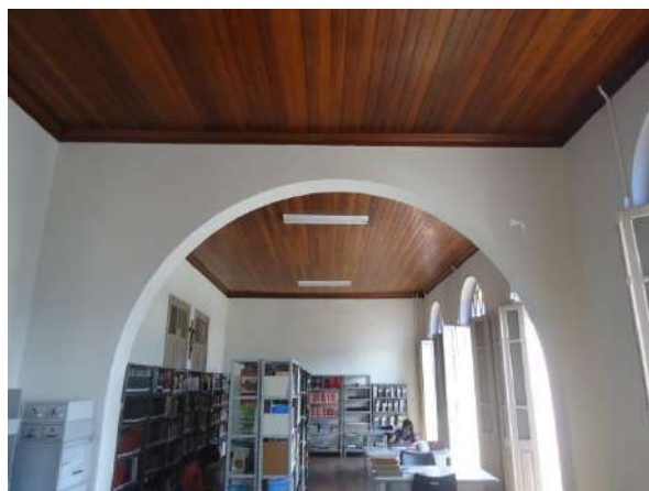
Pará de Minas Prédio Juscelino Kubitschek de Oliveira – Casa da Cultura Forro em madeira da biblioteca de pesquisa no segundo pavimento exibe boa conservação. (Foto 53)
