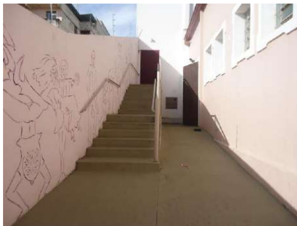
Pará de Minas Prédio Juscelino Kubitschek de Oliveira – Casa da Cultura
