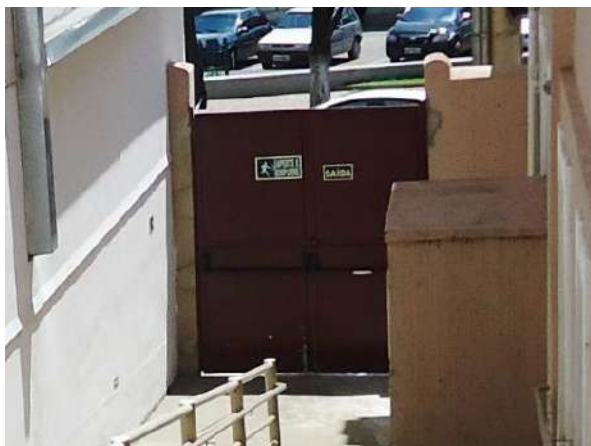
Pará de Minas Prédio Juscelino Kubitschek de Oliveira – Casa da Cultura O portão metálico na lateral direita da edificação se encontra em bom estado de conservação. (Foto 60)
