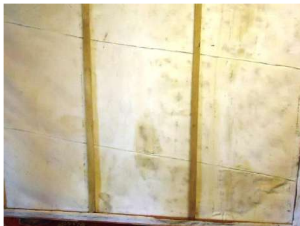
Pará de Minas Telas da Antiga Matriz de Nossa Senhora da Piedade Chassi bem conservado, o reentelamento exibe algumas manchas. (foto 40)
