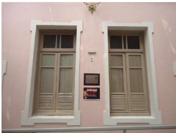
Pará de Minas Prédio Juscelino Kubitschek de Oliveira – Casa da Cultura Janelas do átrio em madeira e vidro em bom estado. (Foto 31) Imagem: Álisson Margotti – 16/10/2018
