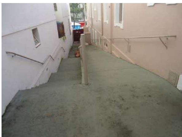
Pará de Minas Prédio Juscelino Kubitschek de Oliveira – Casa da Cultura
