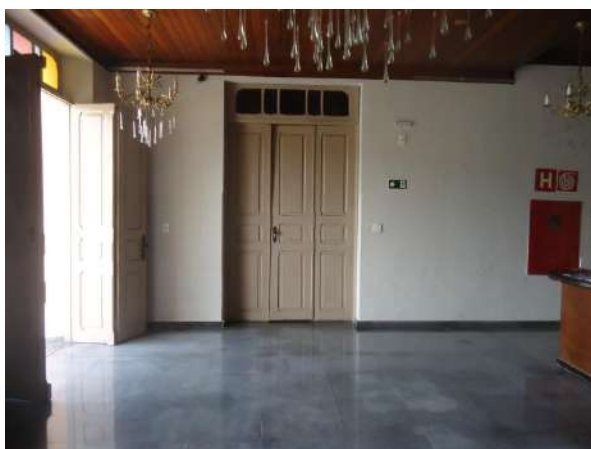
Pará de Minas Prédio Juscelino Kubitschek de Oliveira – Casa da Cultura Porta no hall em madeira e vidro bem conservada. (Foto 27) Imagem: Álisson Margotti – 16/10/2018
