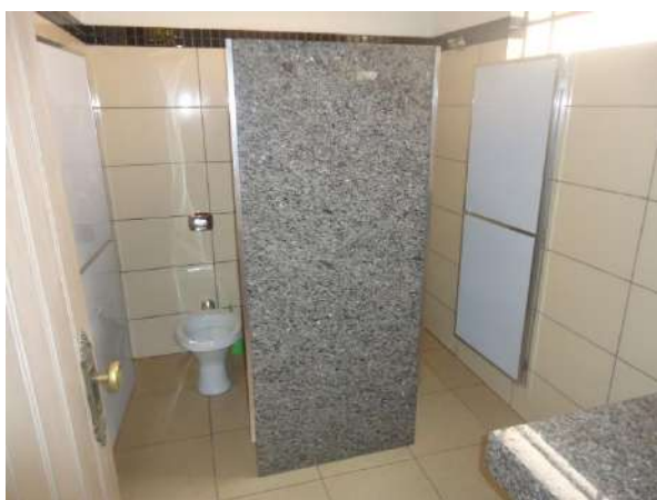
Pará de Minas Prédio Juscelino Kubitschek de Oliveira – Casa da Cultura As cerâmicas dos lavados se encontram em bom estado de conservação.
