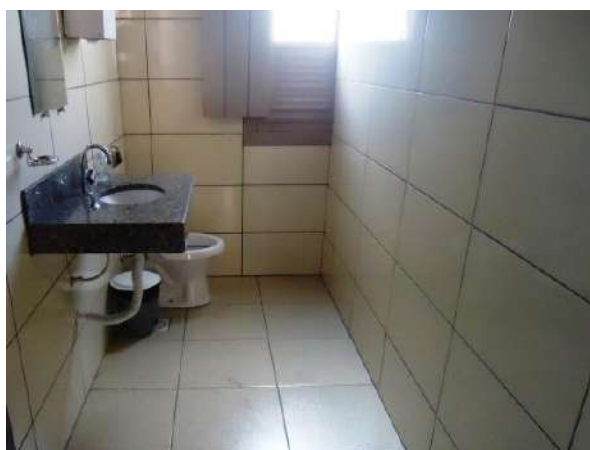
Pará de Minas Prédio Juscelino Kubitschek de Oliveira – Casa da Cultura Lavado do segundo pavimento, próximo à biblioteca apresenta revestimentos bem conservados.
