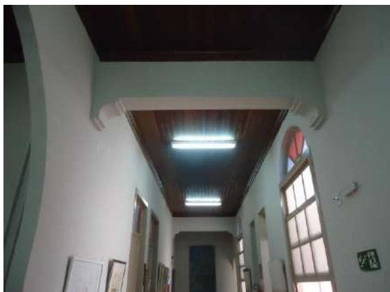
Pará de Minas Prédio Juscelino Kubitschek de Oliveira – Casa da Cultura Detalhe das vigas no 2º pav. em bom estado. (Foto 06) Imagem: Álisson Margotti – 16/10/2018
