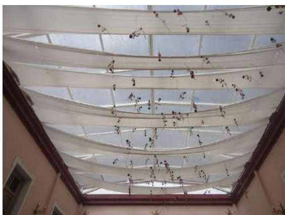
Pará de Minas Prédio Juscelino Kubitschek de Oliveira – Casa da Cultura Detalhe cobertura metálica em bom estado. (Foto 08) Imagem: Álisson Margotti – 16/10/2018
