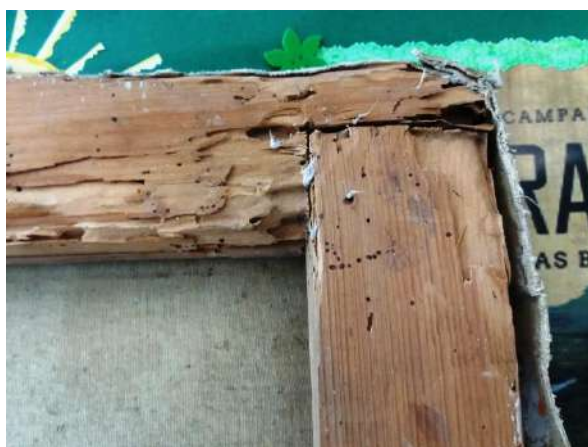
Pará de Minas Telas da Antiga Matriz de Nossa Senhora da Piedade Chassi sob ataque de insetos xilófagos e reentelamento exibindo manchas. (foto 37) Imagem: Álisson Margotti – 12/11/2018
