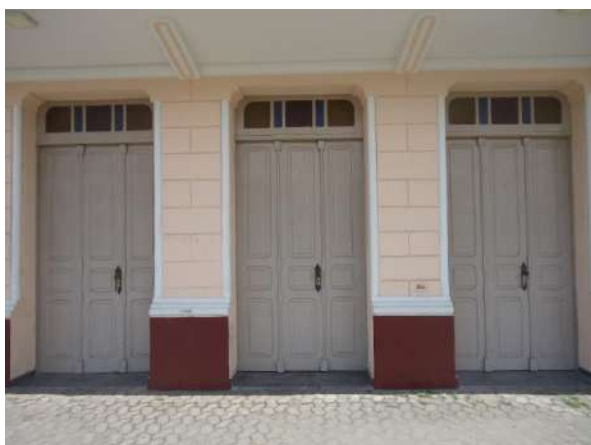
Pará de Minas Prédio Juscelino Kubitschek de Oliveira – Casa da Cultura Portas em estilo francês, em madeira e três folhas, com chapas adornadas, em bom estado. Apresentam cinco bandeiras em diferentes dimensões em vidros texturizados e colorizados. Dão acesso à edificação.
