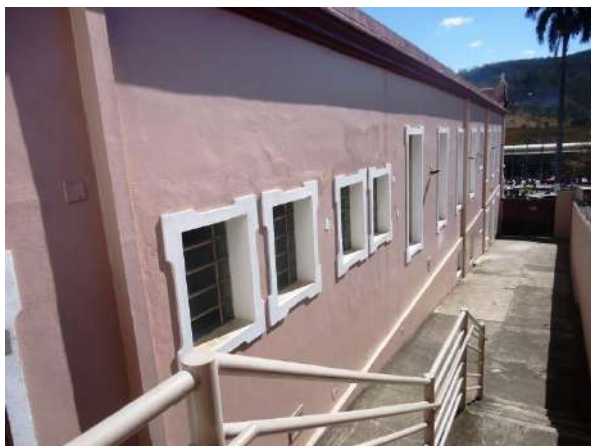
Pará de Minas Prédio Juscelino Kubitschek de Oliveira – Casa da Cultura Vista da fachada lateral esquerda bem conservada. (Foto 02) Imagem: Álisson Margotti – 16/10/2018
