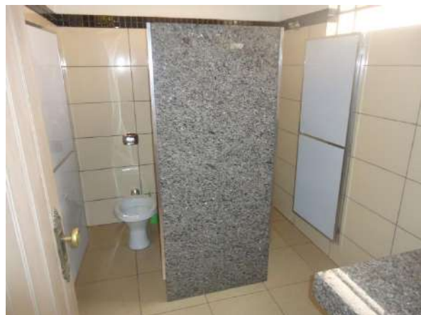
Pará de Minas Prédio Juscelino Kubitschek de Oliveira – Casa da Cultura Revestimentos dos banheiros também se encontram em bom estado de conservação. (Foto 46) Imagem: Álisson Margotti – 16/10/2018
