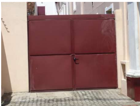
Pará de Minas Prédio Juscelino Kubitschek de Oliveira – Casa da Cultura Portão metálico na lateral esquerda do bem apresenta bom estado de conservação. (Foto 37) Imagem: Álisson Margotti – 16/10/2018
