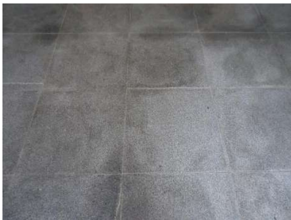
Pará de Minas Prédio Juscelino Kubitschek de Oliveira – Casa da Cultura Granito cinza em bom estado nos pisos do hall, de artes e biblioteca de empréstimos do 1º piso do bem tombado. (Foto 41) Imagem: Álisson Margotti – 16/10/2018
