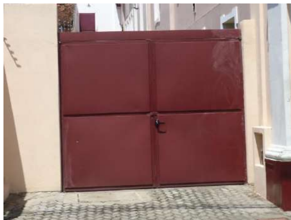
Pará de Minas Prédio Juscelino Kubitschek de Oliveira – Casa da Cultura Na lateral esquerda do bem portão metálico bem conservado. (Foto 61)
