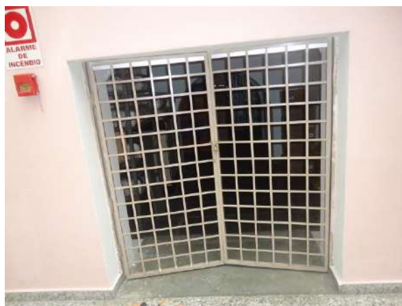
Pará de Minas Prédio Juscelino Kubitschek de Oliveira – Casa da Cultura Portinhola de metal de acesso lateral ao porão com estrutura camada pictórica em bom estado. (Foto 34) Imagem: Álisson Margotti – 16/10/2018
