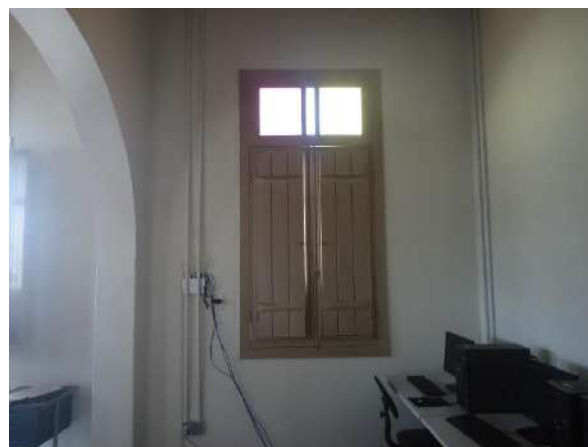
Pará de Minas Prédio Juscelino Kubitschek de Oliveira – Casa da Cultura Janela do 2º piso em madeira e vidro em bom estado. (Foto 30) Imagem: Álisson Margotti – 16/10/2018
