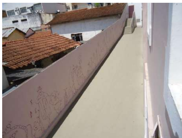
Pará de Minas Prédio Juscelino Kubitschek de Oliveira – Casa da Cultura Muro e área externa lateral direita do bem apresentando bom estado de conservação. (Foto 59) Imagem: Álisson Margotti – 16/10/2018
