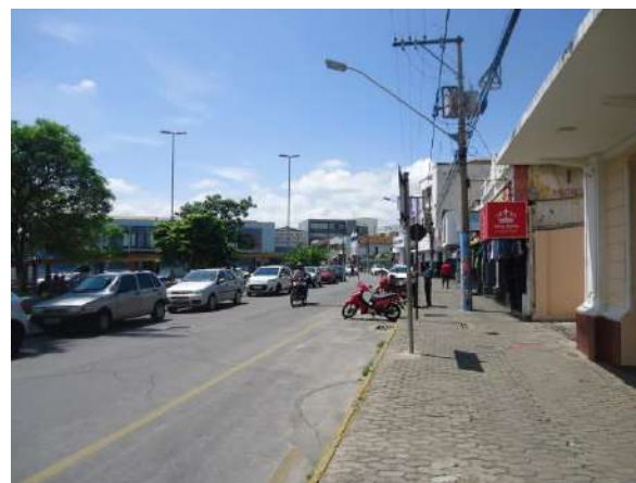
Pará de Minas Prédio Juscelino Kubitschek de Oliveira – Casa da Cultura Imagem com vista para sudeste, edificações com cerca de 2 pavimentos e trânsito intenso. (Foto 68) Imagem: Álisson Margotti – 16/10/2018
