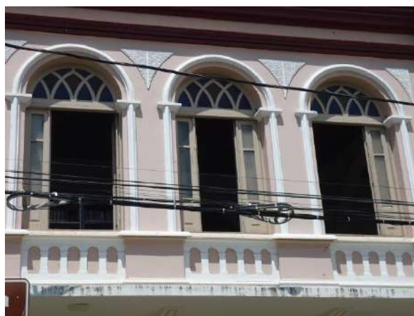
Pará de Minas Prédio Juscelino Kubitschek de Oliveira – Casa da Cultura Janela do 2º piso em madeira e vidro em bom estado. (Foto 28) Imagem: Álisson Margotti – 16/10/2018
