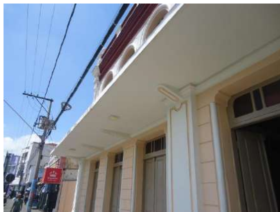
Pará de Minas Prédio Juscelino Kubitschek de Oliveira – Casa da Cultura A marquise na fachada frontal bem conservada. (Foto 07) Imagem: Álisson Margotti – 16/10/2018
