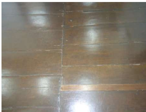
Pará de Minas E M de Artes e Ofícios SICA Assoalho em madeira em uma das salas do térreo apresentando boa conservação. (foto 31)
