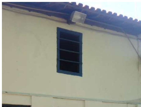
Pará de Minas E M de Artes e Ofícios SICA Janela em madeira de uma folha, com enquadramento e gradeamento em madeira no pavimento térreo da fachada posterior do bem apresenta bom estado de conservação. (foto 29)
