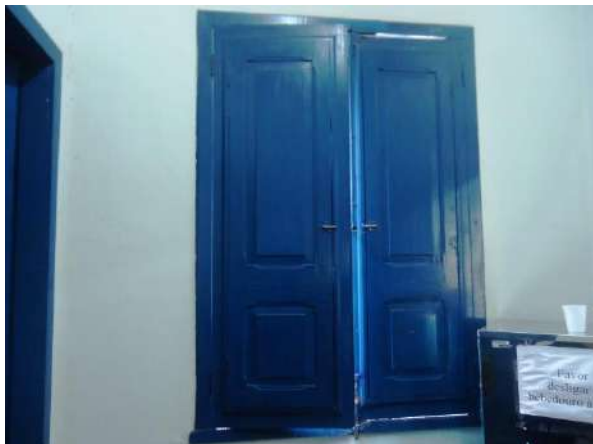
Pará de Minas E M de Artes e Ofícios SICA Vista interna das janelas francesas em madeira na fachada frontal do bem apresentam leve ressecamento e a camada pictórica está bem conservada. (foto 26)
