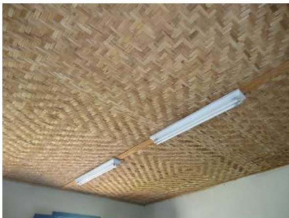
Pará de Minas E M de Artes e Ofícios SICA Esteira de uma das salas de exposições com trançado deslocado e leve abaulamento à esquerda da imagem. (foto 37)
