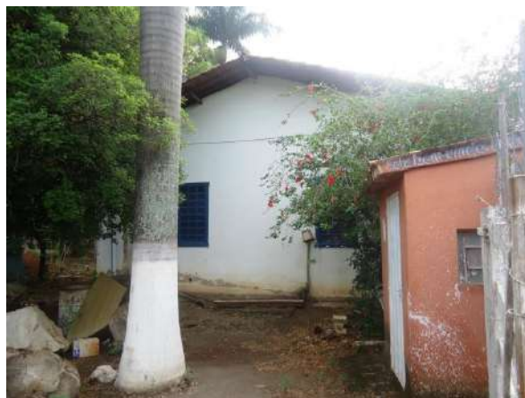
Pará de Minas E M de Artes e Ofícios SICA Fachada lateral direita. (foto 03)
