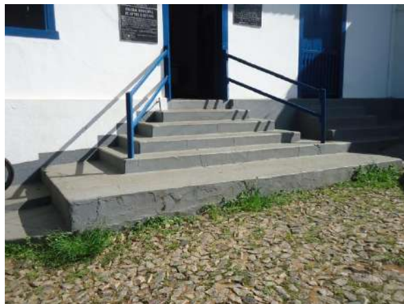
Pará de Minas E M de Artes e Ofícios SICA A escadaria do acesso principal exibe apenas algumas trincas. (foto 40) Imagem: Álisson Margotti – 26/11/2018
