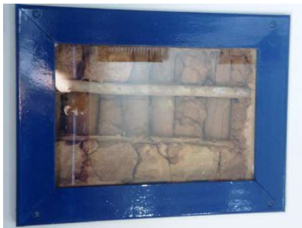
Pará de Minas E M de Artes e Ofícios SICA Detalhe da estrutura em madeira e barro, pau a pique, em uma das salas de exposição do térreo. (foto 09)
