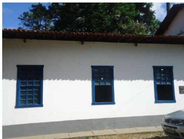
Pará de Minas E M de Artes e Ofícios SICA Reboco externo e pintura à óleo apresentam bom estado de conservação. (foto 17) Imagem: Álisson Margotti – 26/11/2018
