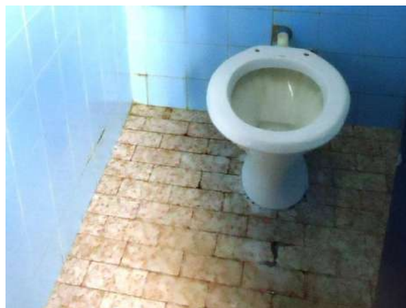
Pará de Minas E M de Artes e Ofícios SICA Piso cerâmico dos banheiros estão bem conservados. (foto 33) Imagem: Álisson Margotti – 26/11/2018
