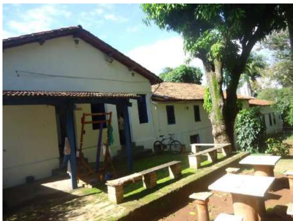
Pará de Minas E M de Artes e Ofícios SICA Fachada posterior (foto 02)
