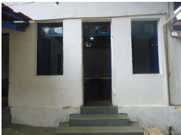
Pará de Minas E M de Artes e Ofícios SICA A escadaria dos fundos que dá acesso ao deck e ao quintal em bom estado de conservação. (foto 41) Imagem: Álisson Margotti – 26/11/2018
