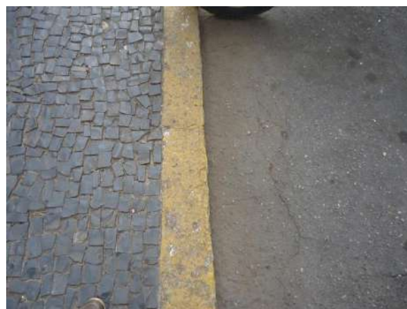
Pará de Minas Praças Torquato de Almeida e Francisco Torquato Trecho da via sem sarjeta o que favorece alagamentos nas vias das praças. (Foto 12)
