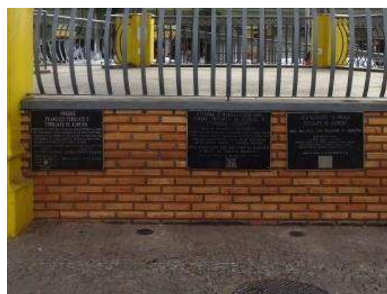
Pará de Minas Praças Torquato de Almeida e Francisco Torquato Placas de identificação instaladas na alvenaria do coreto das Praças Torquato de Almeida e Francisco Torquato. (Foto 49)
