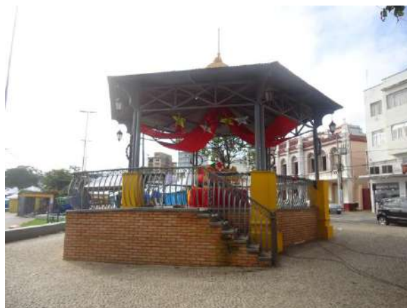
Pará de Minas Praças Torquato de Almeida e Francisco Torquato Vista posterior do coreto das praças em bom estado de conservação.
