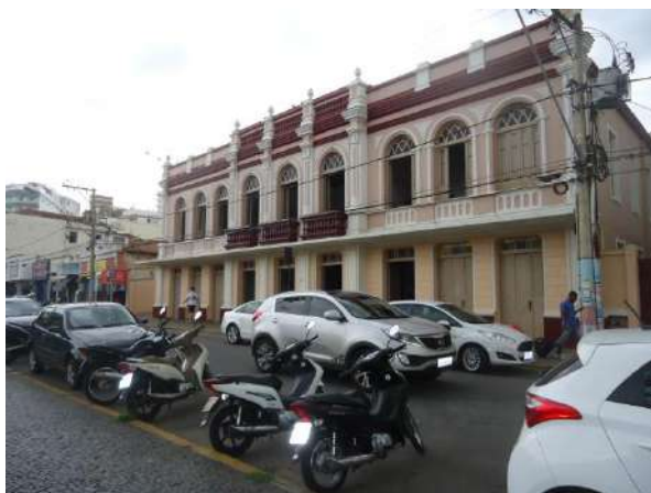
Pará de Minas Praças Torquato de Almeida e Francisco Torquato Edificações de pavimento único e sobrados no entorno do bem tombado, à direita o Prédio Juscelino Kubitschek de Oliveira – Casa da Cultura. (Foto 31)
