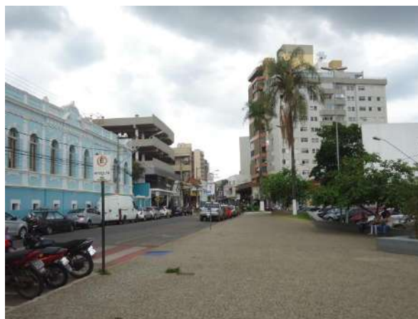
Pará de Minas Praças Torquato de Almeida e Francisco Torquato O bem tombado Escola Estadual Torquato de Almeida e, ao fundo, edifícios de múltiplos de até quinze pavimentos. (Foto 32)
