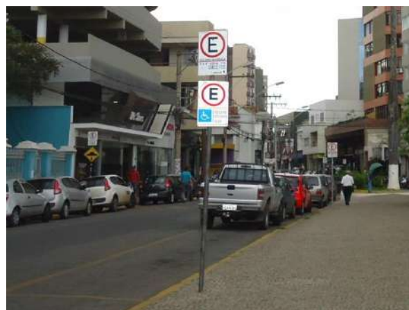
Pará de Minas Praças Torquato de Almeida e Francisco Torquato Placa de trânsito no bem tombado exibindo oxidação. (Foto 09)
