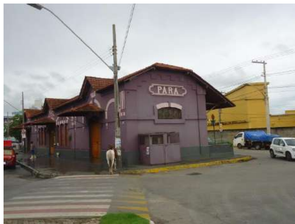
Pará de Minas Antiga Estação Ferroviária Fachada lateral esquerda. (foto 03)
