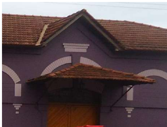
Pará de Minas Antiga Estação Ferroviária Frontão na esquerda da fachada frontal em bom estado. (foto 09) Imagem: Álisson Margotti – 05/11/2018
