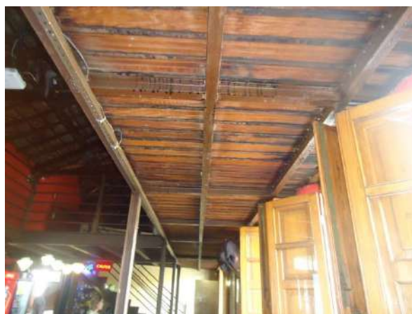
Pará de Minas Antiga Estação Ferroviária Estrutura de aço do mezanino sobre parte da área de shows bem conservada. (foto 42)
