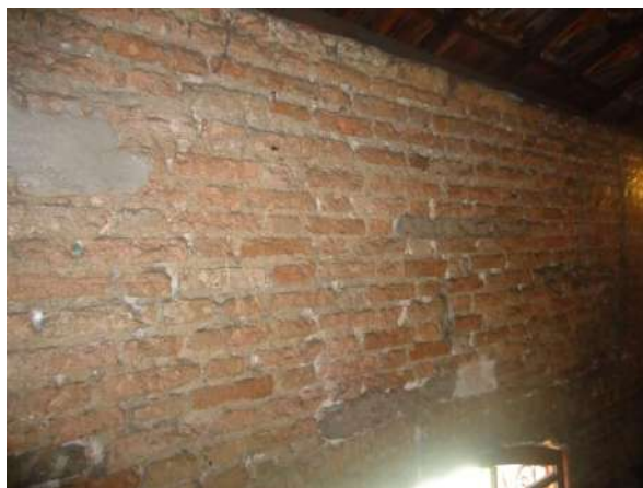
Pará de Minas Antiga Estação Ferroviária Detalhe alvenaria exposta, tijolo autoportante No interior do bem tombado. (foto 11)
