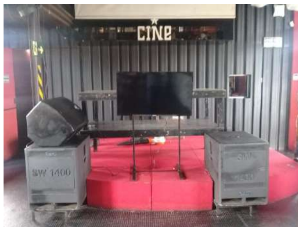
Pará de Minas Antiga Estação Ferroviária Parede metálica entre o pub e o cinema que recebe vedação acústica, estrutura e camada pictórica em bom estado de conservação. (foto 30)
