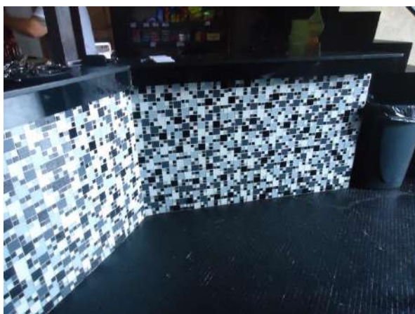
Pará de Minas Antiga Estação Ferroviária Ladrilhos do balcão do piso térreo em bom estado de conservação. (foto 16)
