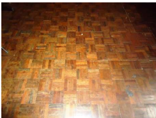
Pará de Minas Antiga Estação Ferroviária Piso em madeira da sala de cinema bastante desgasta (foto 33) Imagem: Álisson Margotti – 29/10/2018
