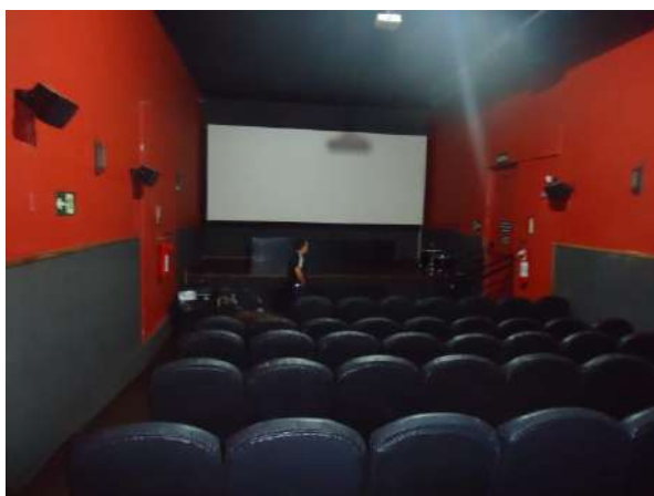
Pará de Minas Antiga Estação Ferroviária Forro de gesso na sala de cinema em bom estado de conservação. (foto 41)
