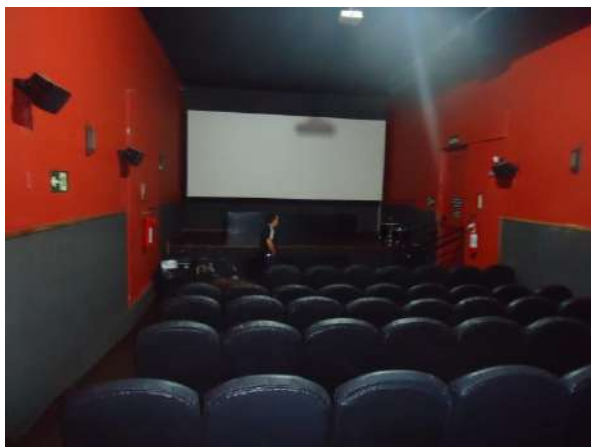
Pará de Minas Antiga Estação Ferroviária Reboco, camada pictórica e carpete nas paredes apresentam bom estado de conservação. (foto 14)
