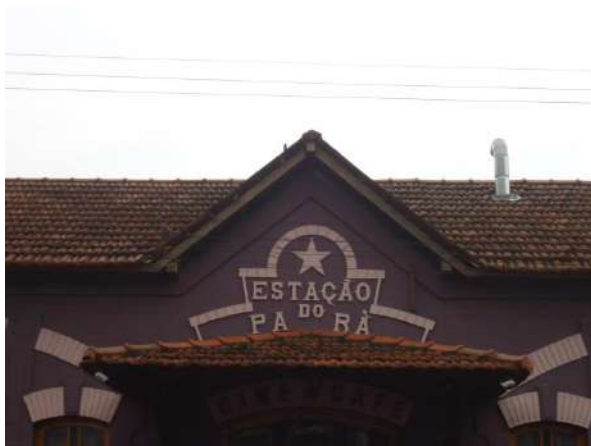
Pará de Minas Antiga Estação Ferroviária Frontão central em bom estado de conservação. (foto 08) Imagem: Álisson Margotti – 05/11/2018
