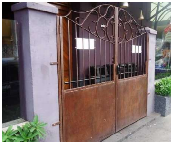
Pará de Minas Antiga Estação Ferroviária Muro da fachada posterior e portão em ferro bem conservados. (foto 47) Imagem: Álisson Margotti – 05/11/2018
