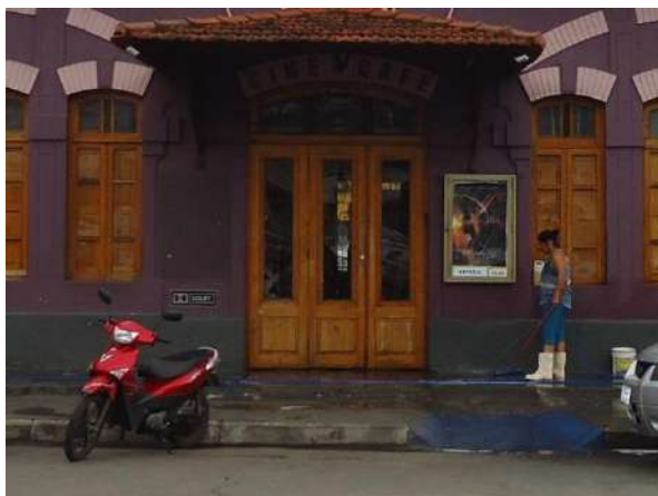
Pará de Minas Antiga Estação Ferroviária Porta principal na fachada frontal do bem exibe bom estado de conservação da madeira, vidros e ferragens e de seus elementos artísticos apenas o enquadramento em massa exibe desgaste. (foto 19)
