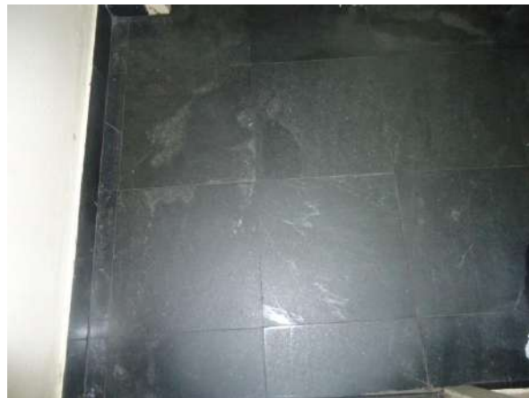
Pará de Minas Antiga Estação Ferroviária Cerâmica do banheiro do térreo bem conservada. (foto 36)
