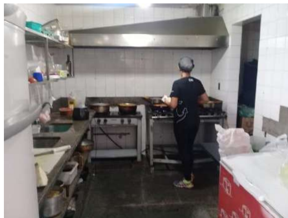
Pará de Minas Antiga Estação Ferroviária Revestimentos cerâmicos da cozinha, necessita de melhor limpeza mas está bem conservado. (foto 15)
