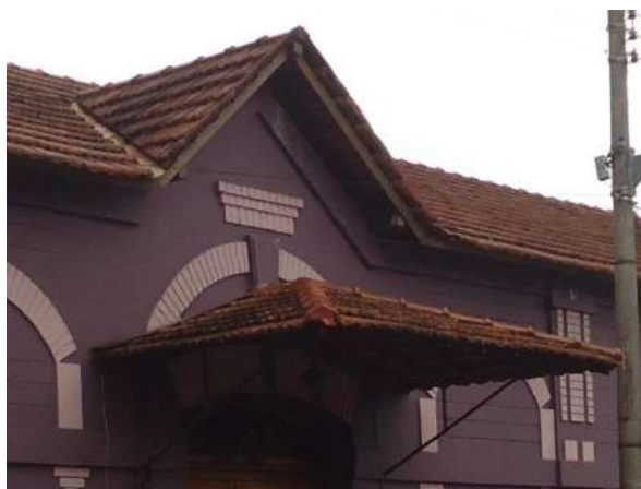
Pará de Minas Antiga Estação Ferroviária Frontão na direita da fachada frontal em bom estado. (foto 10) Imagem: Álisson Margotti – 05/11/2018
