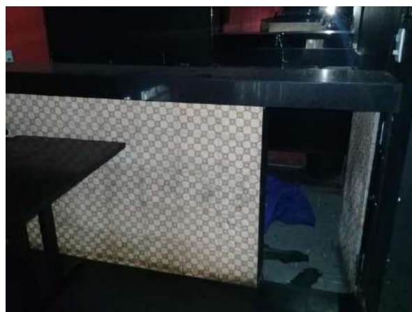
Pará de Minas Antiga Estação Ferroviária Cerâmicas do balcão do mezanino se apresentam bem conservada. (foto 17)
