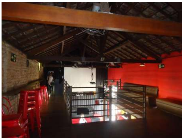
Pará de Minas Antiga Estação Ferroviária Mezanino e seu piso de ferro em bom estado de conservação. (foto 39)
