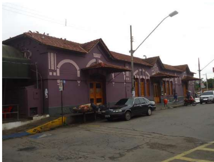
Pará de Minas Antiga Estação Ferroviária Fachada frontal (foto 01)
