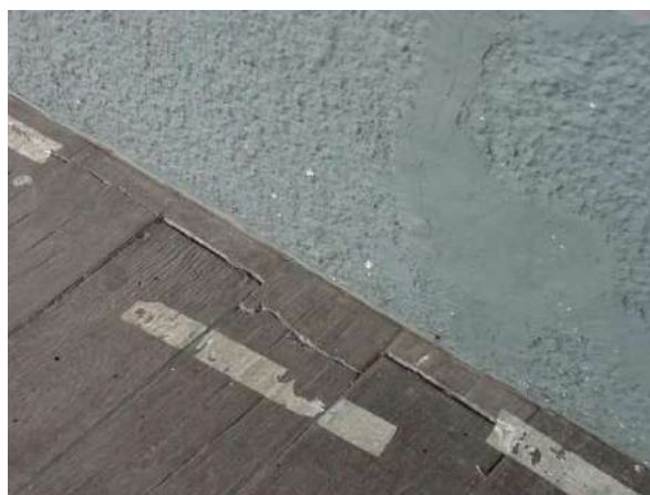
Pará de Minas Antiga Estação Ferroviária Porcelanato imitando madeira na varanda externa exibindo desgastes e rachaduras. (foto 38)
