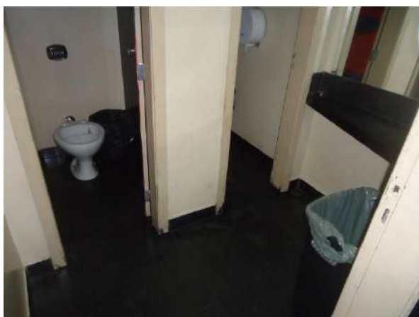
Pará de Minas Antiga Estação Ferroviária Emborrachado do banheiro do cinema bem conservado. (foto 37)
