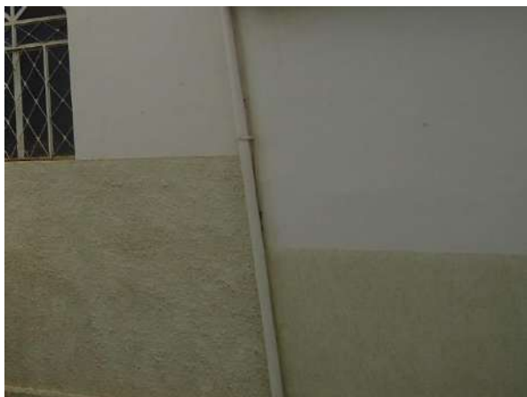
Pará de Minas Asilo Padre José Pereira Coelho Reboco e pinturas à base de água da fachada posterior da Capela em bom estado de conservação.
