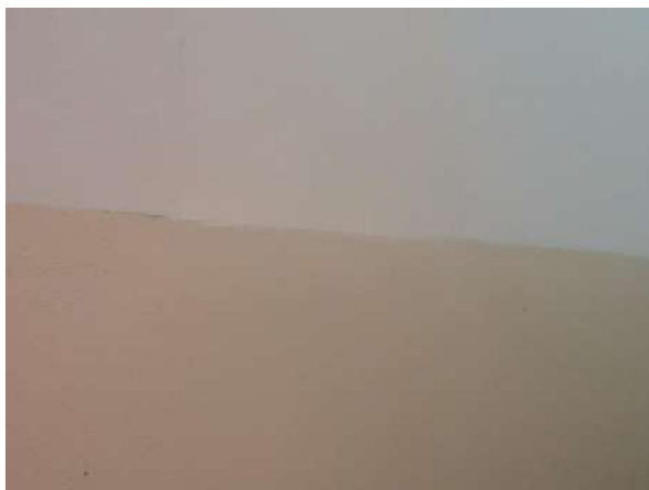
Pará de Minas Asilo Padre José Pereira Coelho Reboco e pinturas à óleo e à base de água das salas de aula em bom estado de conservação.
