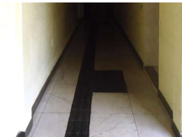
Pará de Minas Asilo Padre José Pereira Coelho Piso podotátil em um dos corredores Se apresenta bem conservado. (foto 43)
