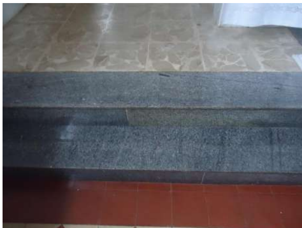
Pará de Minas Asilo Padre José Pereira Coelho Granito e cerâmica no piso do altar em bom estado de conservação. (foto 41)
