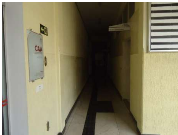
Pará de Minas Asilo Padre José Pereira Coelho Reboco, textura e camadas pictóricas dos corredores estão bem conservados.
