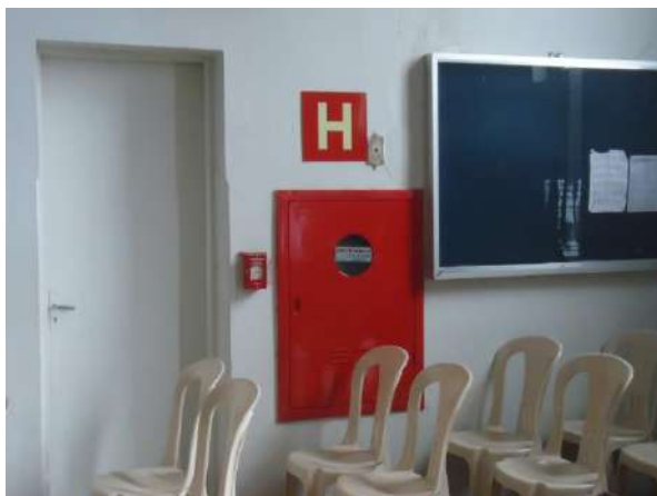
Pará de Minas Asilo Padre José Pereira Coelho Abrigo para mangueira no interior da Capela. (foto 56) Imagem: Álisson Margotti – 25/10/2018
