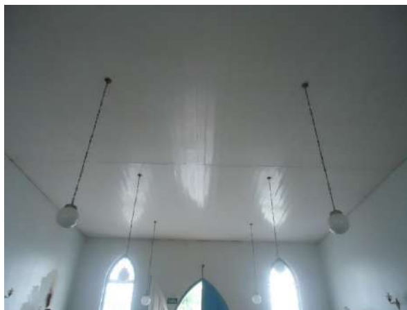
Pará de Minas Asilo Padre José Pereira Coelho Forro de PVC da Capela de Santo Antônio em bom estado mas apresenta algum acúmulo de sujidades. (foto 49)
