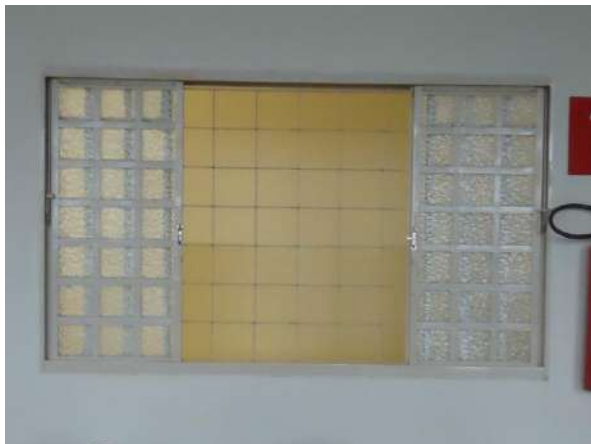
Pará de Minas Asilo Padre José Pereira Coelho Vista interna da janela do auditório para corredor Interno apresenta bom estado de conservação. (foto 31) Imagem: Álisson Margotti – 25/10/2018
