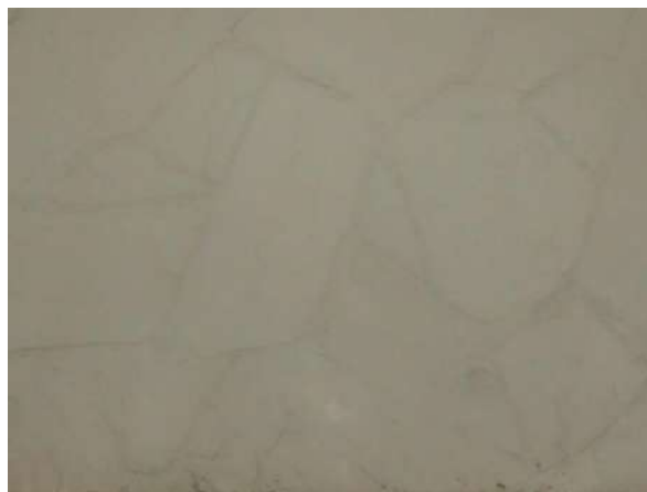
Pará de Minas Asilo Padre José Pereira Coelho Pedras ouro preto no barrado das escadas internas recebem camada pictórica. (foto 20)
