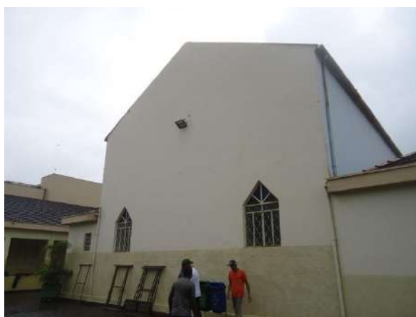
Pará de Minas Asilo Padre José Pereira Coelho Fachada posterior. (foto 04) Imagem: Álisson Margotti – 25/10/2018
