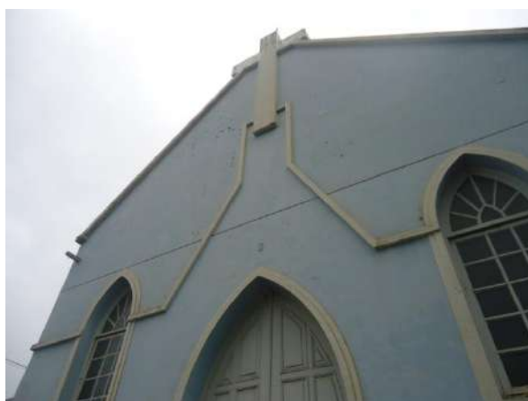
Pará de Minas Asilo Padre José Pereira Coelho Frontão e cimalha simples bem conservados, necessitando apenas de renovação da camada pictórica. (foto 08) Imagem: Álisson Margotti – 25/10/2018
