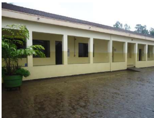
Pará de Minas Asilo Padre José Pereira Coelho A estrutura em vigas e pilares de concreto armado não apresenta danos. (foto 05)
