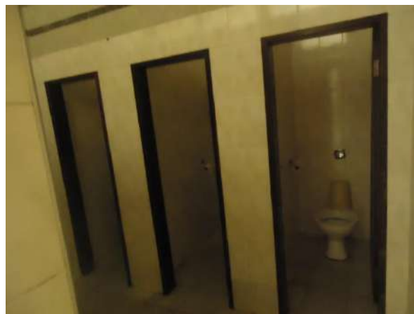
Pará de Minas Asilo Padre José Pereira Coelho Cerâmicas dos banheiros se apresentam bem conservadas.
