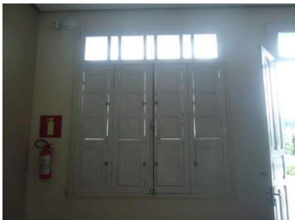
Pará de Minas Asilo Padre José Pereira Coelho Vista interna da janela da fachada frontal apresenta bom estado de conservação. (foto 27)
