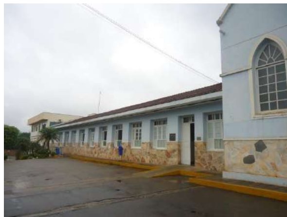
Pará de Minas Asilo Padre José Pereira Coelho Fachada lateral direita recebeu anexo. (foto 03) Imagem: Álisson Margotti – 25/10/2018
