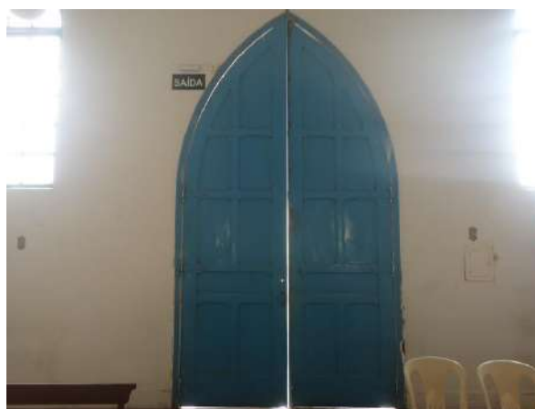
Pará de Minas Asilo Padre José Pereira Coelho Vista interna da porta principal da Capela em bom estado de conservação. (foto 22)
