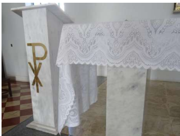
Pará de Minas Asilo Padre José Pereira Coelho Mármore revestindo Altar e púlpito em bom estado de conservação.
