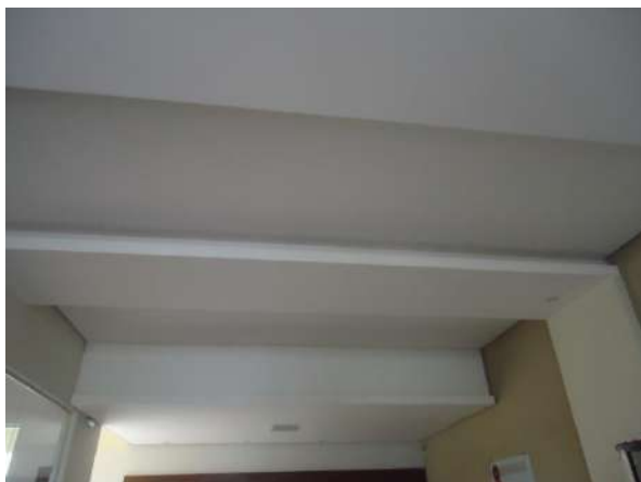
Pará de Minas Asilo Padre José Pereira Coelho Forro de gesso da recepção em bom estado de conservação. (foto 47)
