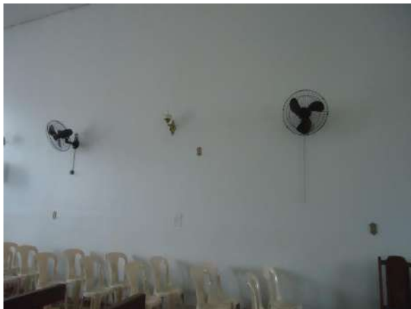
Pará de Minas Asilo Padre José Pereira Coelho Alvenarias do interior da Capela de Santo Antônio estão em bom estado de conservação. (foto 09) Imagem: Álisson Margotti – 25/10/2018
