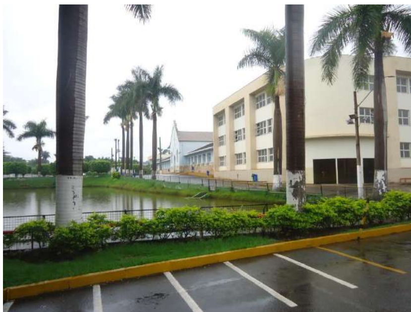
Pará de Minas Asilo Padre José Pereira Coelho Fachada Frontal (foto 01) Imagem: Álison Margotti – 25/10/2018
