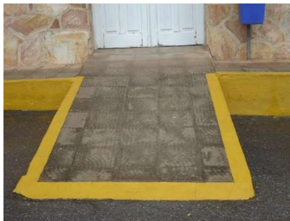
Pará de Minas Asilo Padre José Pereira Coelho Rampa de acesso à recepção da faculdade também se apresenta bem conservada. (foto 53)
