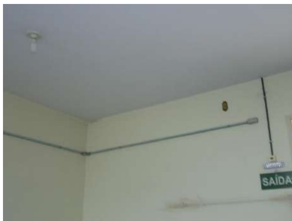
Pará de Minas Asilo Padre José Pereira Coelho Instalações apresentam boas condições de conservação. (foto 55) Imagem: Álisson Margotti – 25/10/2018
