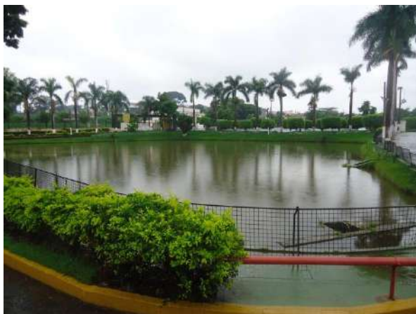
Pará de Minas Asilo Padre José Pereira Coelho Lagoa e jardins em frente à fachada frontal exibem boa manutenção de seus elementos. (foto 52)
