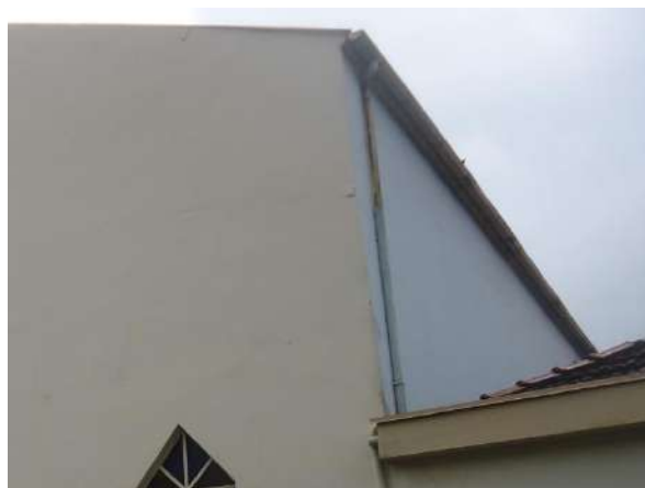
Pará de Minas Asilo Padre José Pereira Coelho Condutores de águas pluviais bem conservados. (foto 07) Imagem: Álisson Margotti – 25/10/2018
