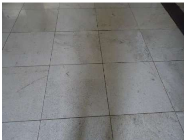
Pará de Minas Asilo Padre José Pereira Coelho Piso cerâmico em uma das salas também exibe boa conservação. (foto 40)
