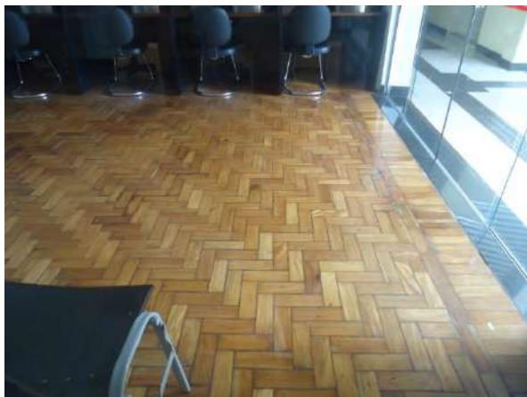
Pará de Minas Asilo Padre José Pereira Coelho Detalhe do piso da sala de informática com piso em tacos.
