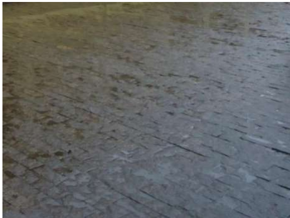
Pará de Minas Asilo Padre José Pereira Coelho Piso de pedra no pátio interno do bem em bom estado de conservação.
