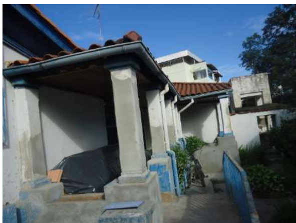
Pará de Minas Casa Maria Capanema Fachada lateral esquerda da edificação. (foto 04)
