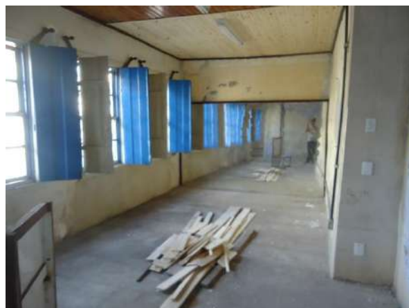
Pará de Minas Casa Maria Capanema Outra sala onde foi feito laje de piso para que possa ser assentado piso de madeira. (foto 41)
