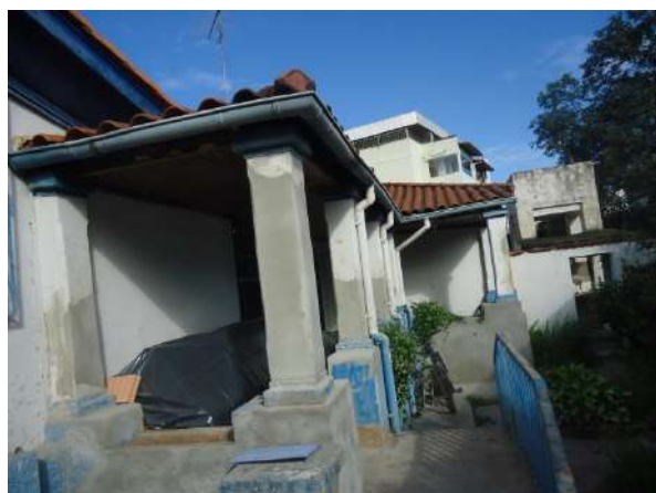
Pará de Minas Casa Maria Capanema Detalhe da varanda que dá acesso ao bem pela fachada lateral esquerda da edificação. (foto 46)
