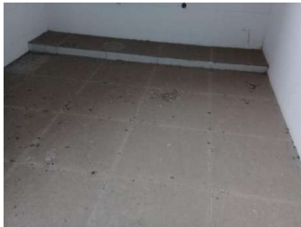
Pará de Minas Centro Literário Pedro Nestor Piso novo da futura copa, comum ao salão do térreo, rampa e palco. (foto 27)
