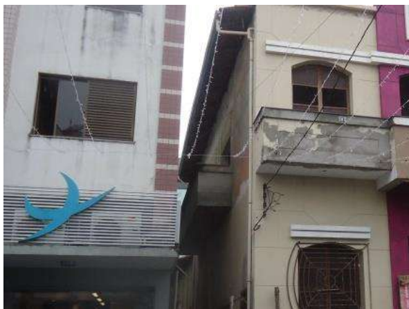
Pará de Minas Centro Literário Pedro Nestor Fachada lateral direita. (foto 02)
