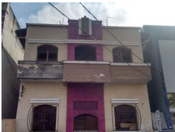
Pará de Minas Centro Literário Pedro Nestor Reboco externo em bom estado, pintura em processo de execução . (foto 12) Imagem: Álisson Margotti – 05/10/2018
