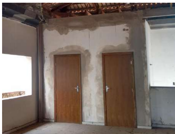
Pará de Minas Centro Literário Pedro Nestor Portas em madeira instaladas no segundo pavimento da edificação. (foto 17)
