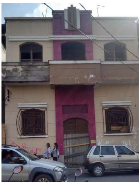
Pará de Minas Centro Literário Pedro Nestor Fachada frontal (foto 01) Imagem: Álison Margotti – 05/10/2018
