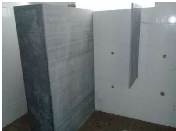
Pará de Minas Centro Literário Pedro Nestor Cerâmica dos banheiros em processo de instalação. (foto 14)
