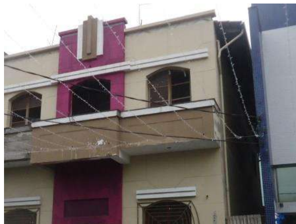
Pará de Minas Centro Literário Pedro Nestor Fachada lateral esquerda. (foto 03)
