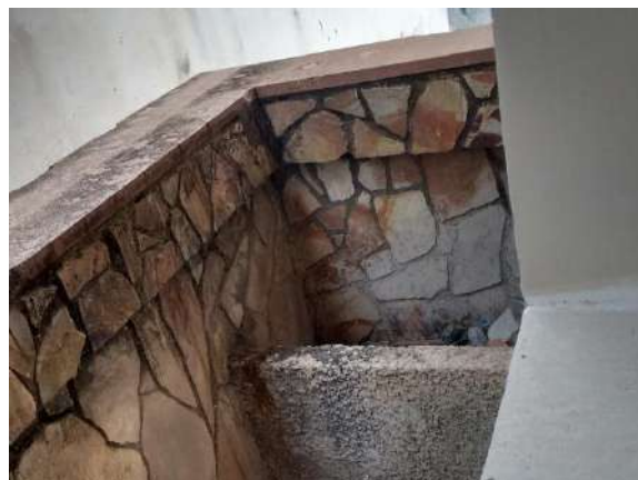
Pará de Minas Centro Literário Pedro Nestor Ouro preto nos guarda-corpos da sacada lateral exibe sujidades e manchas de umidade. (foto 15)
