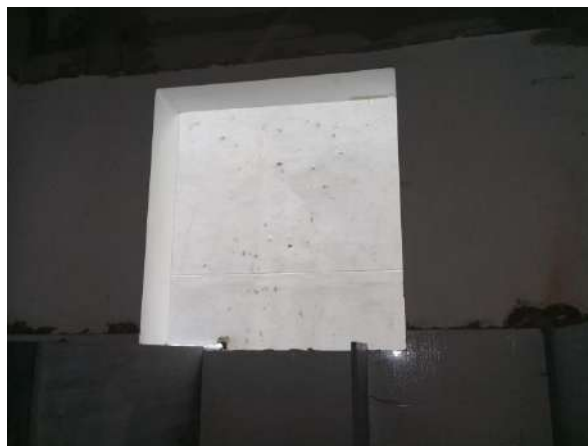
Pará de Minas Centro Literário Pedro Nestor Enquadramento em massa da janela da sala de som já foi restaurado. (foto 23)
