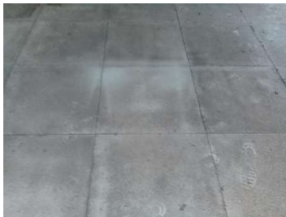
Pará de Minas Centro Literário Pedro Nestor Piso novo mas com acúmulo de pó no salão do pavimento superior. (foto 25)
