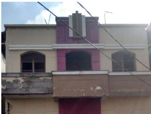
Pará de Minas Centro Literário Pedro Nestor Reboco e pintura externa em bom estado, detalhes do frontão bem conservados. (foto 10) Imagem: Álisson Margotti – 05/10/2018
