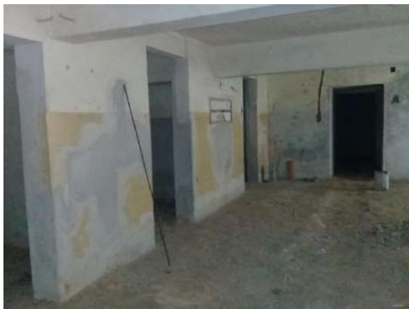
Pará de Minas Centro Literário Pedro Nestor Alvenarias internas em processo de restauração. (foto 08)
