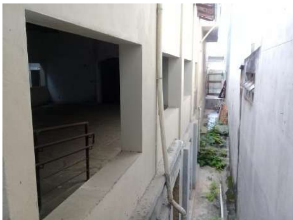
Pará de Minas Centro Literário Pedro Nestor Enquadramentos em massa do salão do térreo exibem bom estado de conservação. (foto 22)
