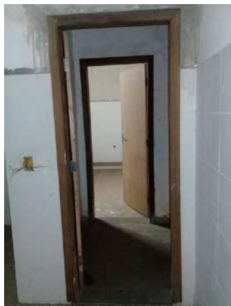
Pará de Minas Centro Literário Pedro Nestor Novos marcos em madeira que serão instalados nos banheiros, copas e salas do Centro Literário. (foto 18)
