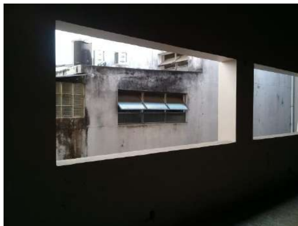
Pará de Minas Centro Literário Pedro Nestor Reboco interno restaurado, a pintura interna ainda não foi iniciada. (foto 11) Imagem: Álisson Margotti – 05/10/2018
