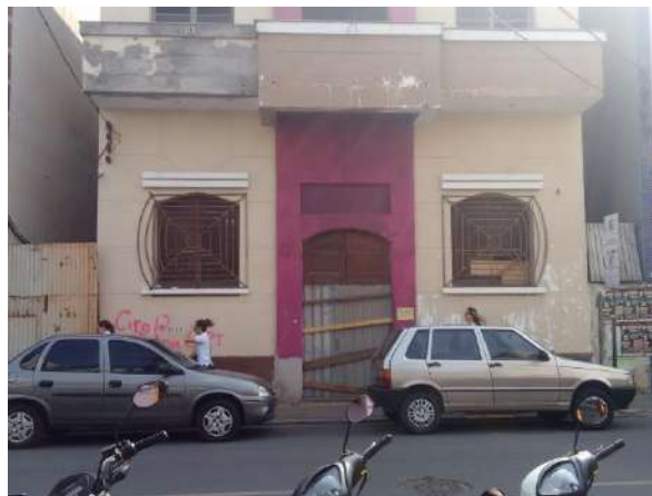
Pará de Minas Centro Literário Pedro Nestor Alvenarias externas em processo de restauração. (foto 09)
