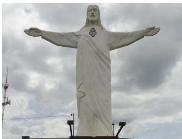
Pará de Minas Cristo Redentor Reboco e pintura da estátua exibem bom estado de conservação. (foto 07)
