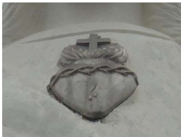
Pará de Minas Cristo Redentor O coração metálico não apresenta danos. (foto 13)
