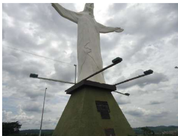
Pará de Minas Cristo Redentor Hastes que compõem a iluminação do bem foram parcialmente destruídas. (foto 22) Imagem: Álisson Margotti – 19/10/2018
