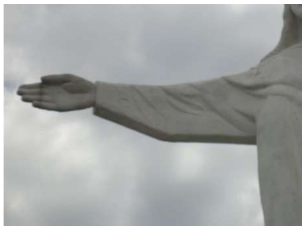
Pará de Minas Cristo Redentor Braço direito do Cristo Redentor exibe reboco e pintura bem conservados. (foto 09) Imagem: Álisson Margotti – 19/10/2018
