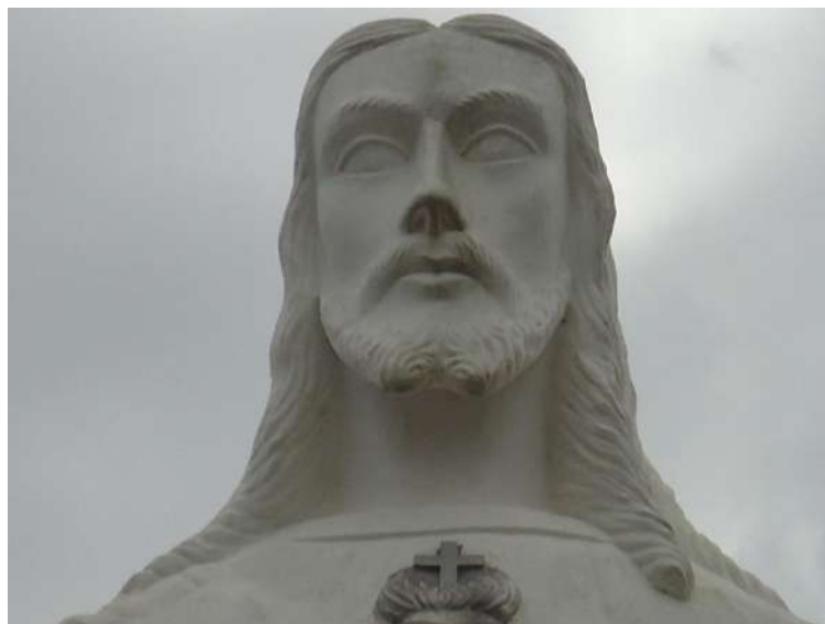
Pará de Minas Cristo Redentor Rosto de Cristo apresenta bom estado de conservação. (foto 08) Imagem: Álisson Margotti – 19/10/2018
