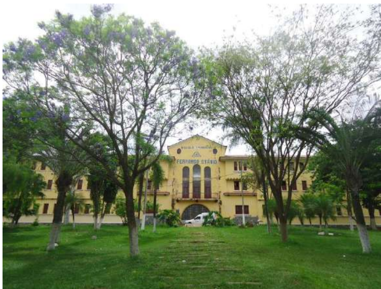
Pará de Minas Escola Estadual Fernando Otávio Fachada frontal (foto 01) Imagem: Álison Margotti – 19/10/2018
