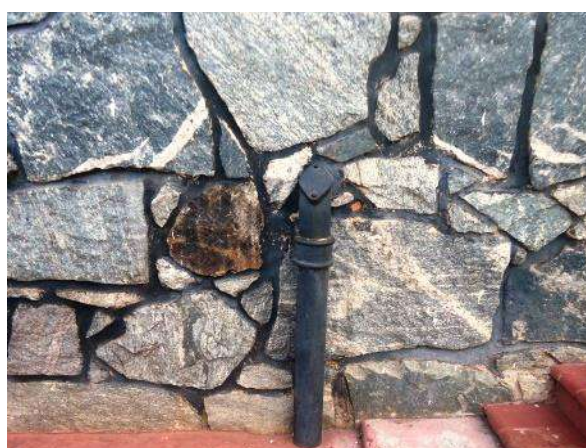
Pará de Minas Escola Estadual Fernando Otávio Condutores de águas pluviais em ferro em bom estado de conservação. (foto 05) Imagem: Álisson Margotti – 19/10/2018
