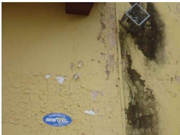
Pará de Minas Escola Estadual Fernando Otávio Câmera de segurança instalada junto à entrada principal do bem. (foto 35)
