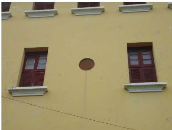
Pará de Minas Escola Estadual Fernando Otávio Alvenarias externas apresentam bom estado de conservação. (foto 09) Imagem: Álisson Margotti – 19/10/2018
