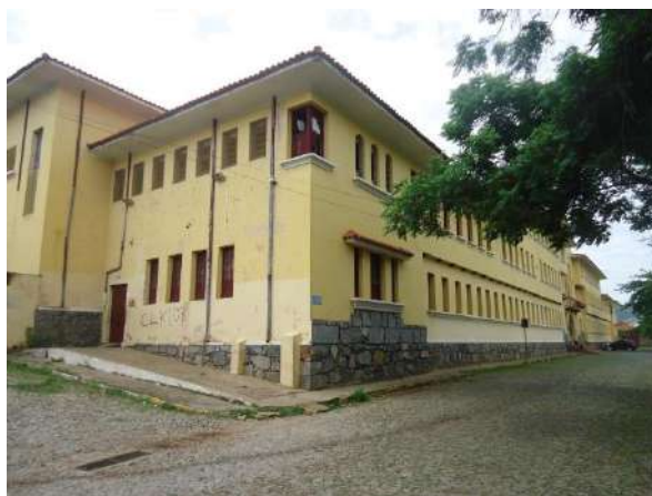
Pará de Minas Escola Estadual Fernando Otávio Peitoris, sobreverga e cachorros em bom estado de conservação mas necessitando de nova camada pictórica. (foto 32)
