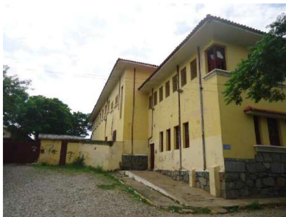
Pará de Minas Escola Estadual Fernando Otávio Fachada lateral direita. (foto 02) Imagem: Álisson Margotti – 19/10/2018
