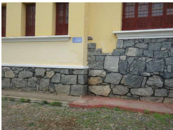
Pará de Minas Escola Estadual Fernando Otávio Reboco e pedras em bom estado de conservação necessitando apenas de limpeza. (foto 11) Imagem: Álisson Margotti – 19/10/2018
