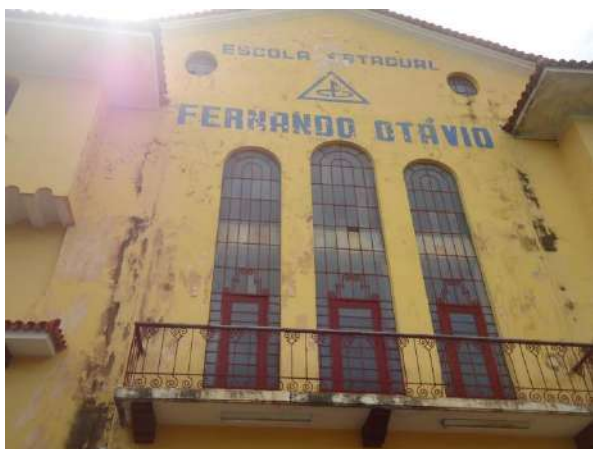
Pará de Minas Escola Estadual Fernando Otávio Janelas rasgadas do 2º pavimento em hall com pé-direito duplo em metal e vidro em bom estado de conservação, mas necessitando de renovação da camada pictórica. (foto 21)
