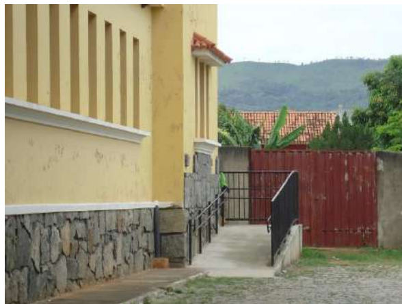
Pará de Minas Escola Estadual Fernando Otávio Trecho do passeio refeito apresenta-se em bom estado. (foto 33)
