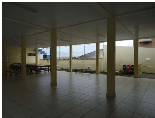
Pará de Minas Escola Estadual Governador Valadares Pilares e vigas do refeitório nos fundos do bem exibem boa conservação. (foto 06)
