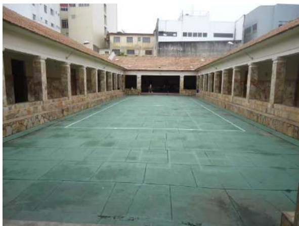
Pará de Minas Escola Estadual Torquato de Almeida Cimentado do pátio interno em bom estado de conservação. (foto 25)
