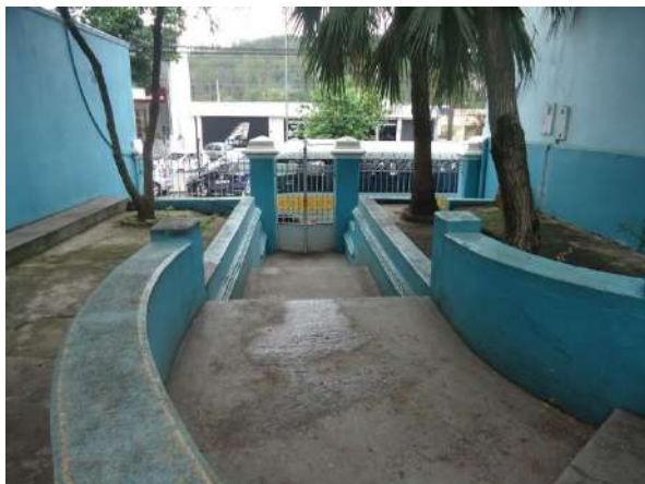
Pará de Minas Escola Estadual Torquato de Almeida Escada apresenta desgaste do piso pelo constante e intenso uso. (foto 34) Imagem: Álisson Margotti – 06/11/2018
