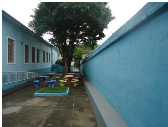
Par  de Minas Escola Estaduai Torquato de Almeida Muro lateral direito da edifica o apresenta bom estado de conserva o. (foto 39)
