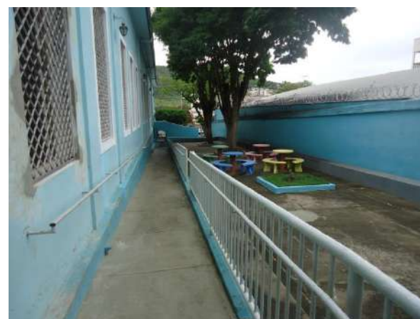
Pará de Minas Escola Estadual Torquato de Almeida Rampa na lateral direita que oferece acessibilidade ao bem apresenta bom estado de conservação. (foto 37) Imagem: Álisson Margotti – 06/11/2018
