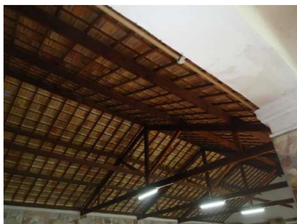
Pará de Minas Escola Estadual Torquato de Almeida Madeiramento do telhado em bom estado. (foto 06)
