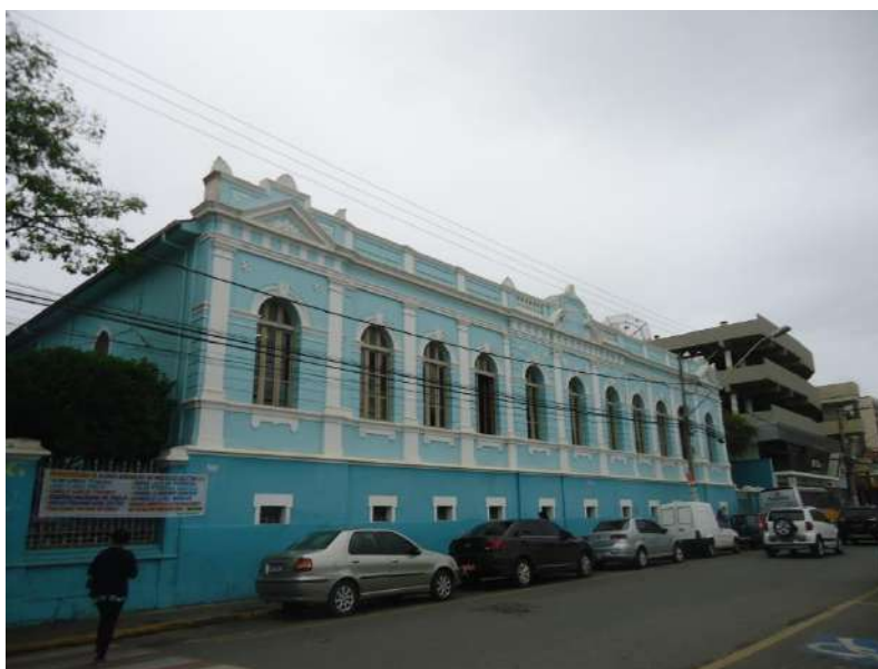
Pará de Minas Escola Estadual Torquato de Almeida Fachada Frontal (foto 01)
