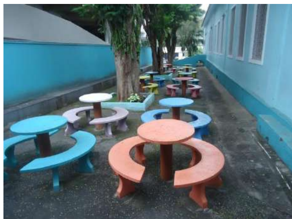
Par  de Minas Escola Estadual Torquato de Almeida Quintal na lateral direita da edifica o seu piso apresenta trincas e manchas de umidade. (foto 40)
