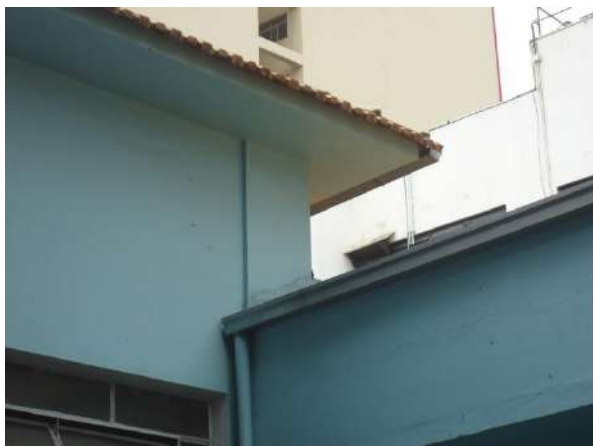
Pará de Minas Escola Estadual Torquato de Almeida Condutores de águas pluviais na lateral esquerda exibem bom estado de conservação. (foto 08)
