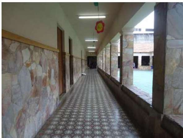
Pará de Minas Escola Estadual Torquato de Almeida As alvenarias do bem tombado apresentam bom estado de conservação. (foto 11) Imagem: Álisson Margotti – 06/11/2018
