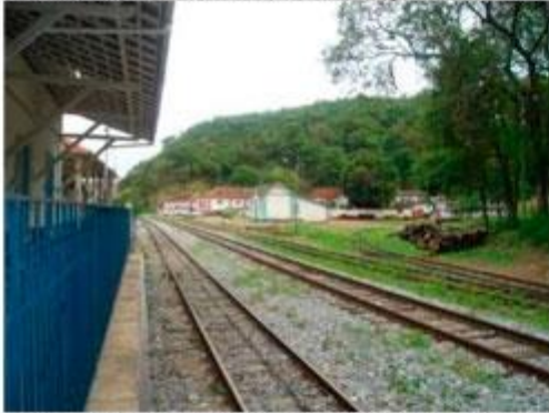
Foto 01 – Vista do conjunto. A frente estação, atrás casa do rádio e vila ferroviária bem ao fundo. Data: 28/10/09.
