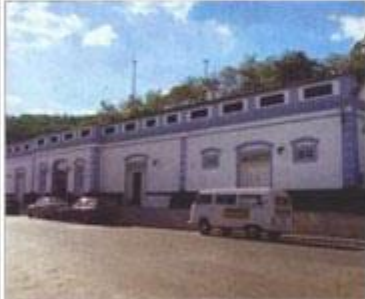
Foto 04 - Vista da outra fachada da estação. Data: 28/10/09.
