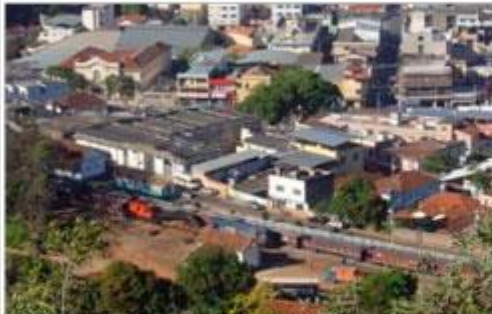
Foto 06 - Vista do conjunto. Data: 28/10/09.
