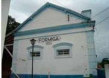
Foto 05 - Detalhe da fachada da estação. Data: 28/10/09.
