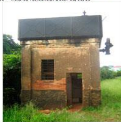
Foto 04 - Vista da caixa d'água. Data: 01/03/10
