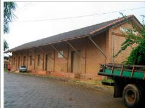
Foto 02 - Vista da estação. Data: 01/03/10
