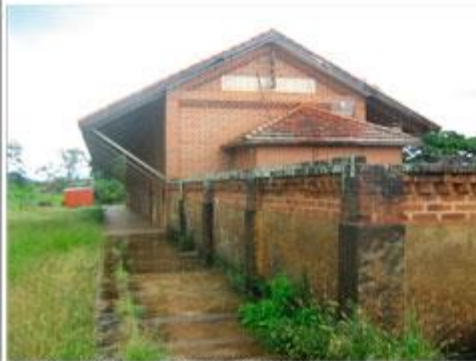
Foto 01 - Vista da estação. Data: 01/03/10
