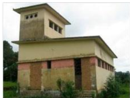
Foto 08 – Vista da subestação elétrica. Data: 02/03/10
