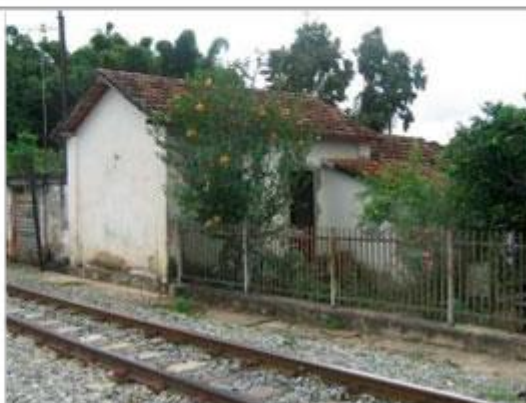
Foto 05 – Vista residência nº 447. Data: 07/03/10
