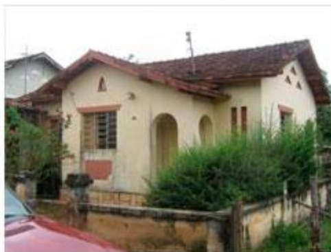
Foto 07 – Vista da residência nº 451. Data: 07/03/10
