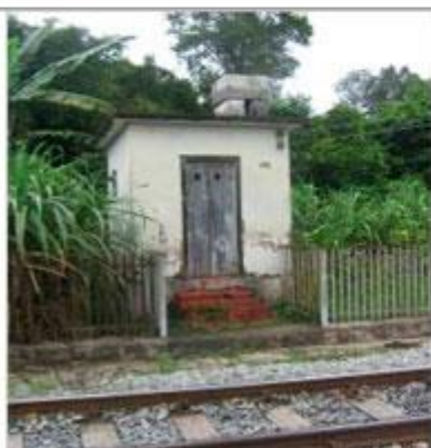
Foto 04 – Vista do banheiro da estação. Data: 07/03/10
