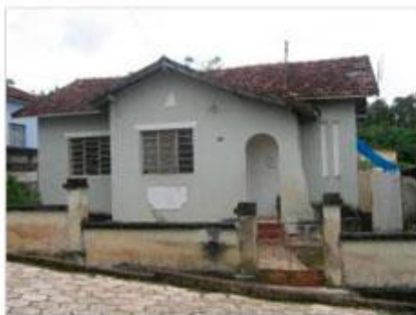
Foto 06 – Vista da residência nº 450. Data: 07/03/10
