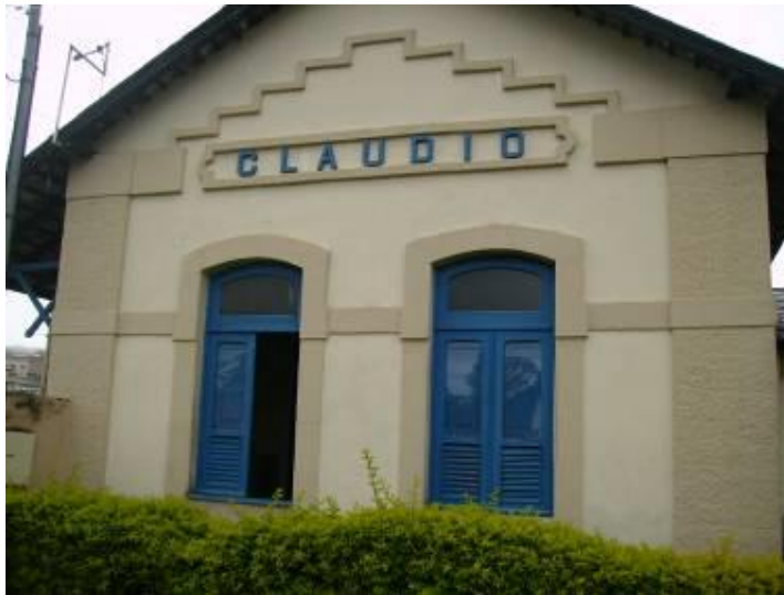
Foto 01 – Vista da fachada lateral esquerda. Data: 27/10/09.
