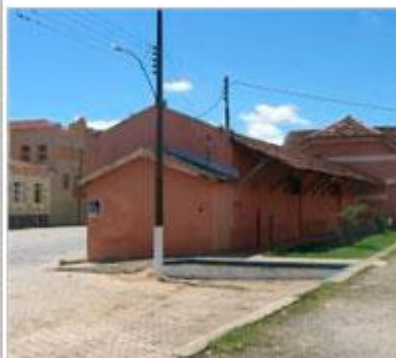
Foto 03 – Vista da estação. Data: 22/02/10
