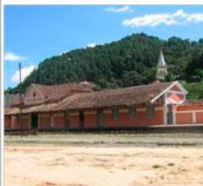
Foto 02 – Vista da estação. Data: 21/02/10
