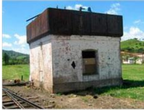
Foto 04 – caixa d'água. Data: 22/02/10
