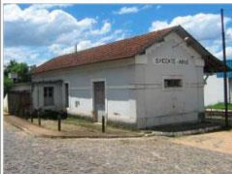
Foto 02 – Vista da estação. Data: 08/03/10
