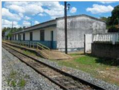
Foto 05 – Vista do alojamento. Data: 08/03/10
