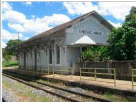
Foto 03 – Vista da estação. Data: 08/03/10
