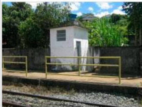
Foto 04 – Vista do banheiro. Data: 08/03/10
