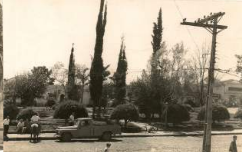
Figura 32: Praça São Sebastião parte próxima ao Banco do Brasil.
