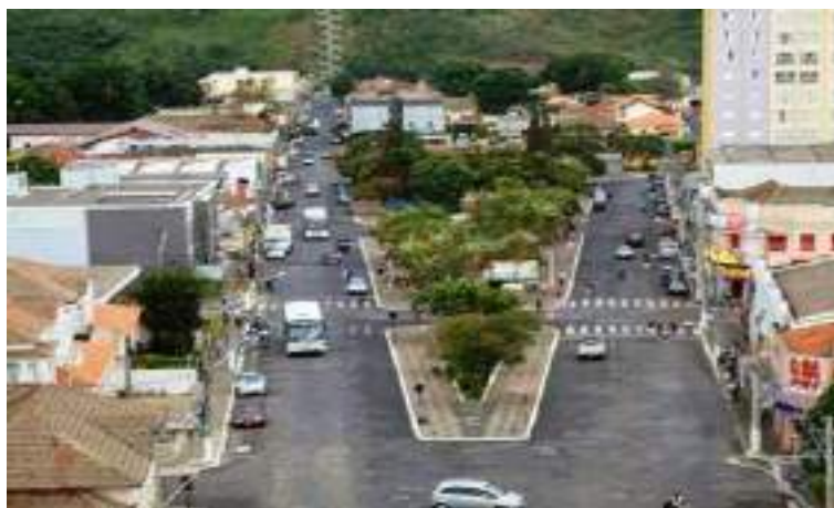
Figura 116: Foto da praça antes da intervenção.
