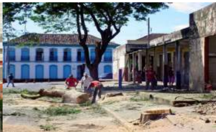
Figura 117: Mercado municipal antes da demolição.
