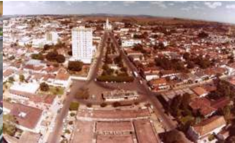
Figura 119: Vista aérea da praça antes da intervenção.
