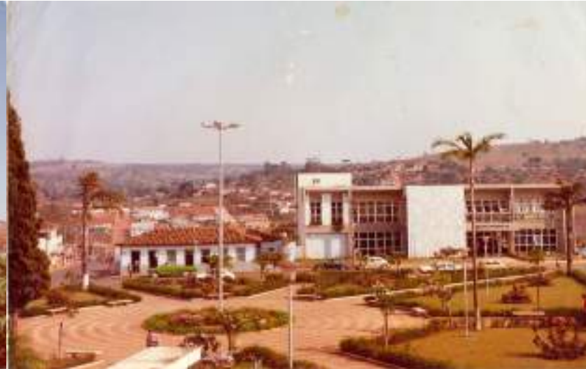
Figura 34: Praça São Sebastião já com a pavimentação atual.
