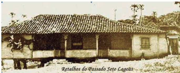
Parte vazada no declive do terreno. Por detrás são troncos de árvores, não os sustentáculos, que não estão à mostra
