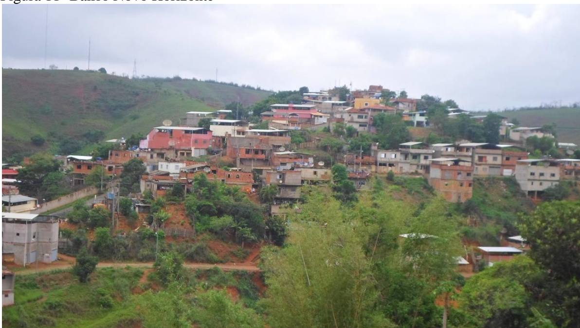
Figura 11- Bairro Novo Horizonte
