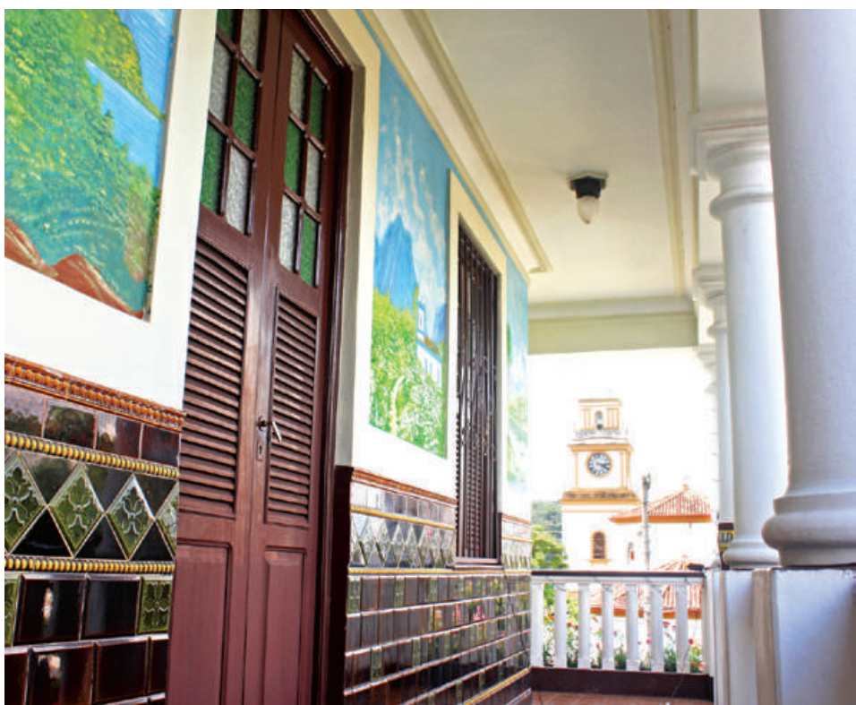
VARANDA QUE CERCA A FRENTE E A LATERAL DO PALACETE, COM SUAS PINTURAS, AZULEJOS E MUITOS DETALHES MANTIDOS
