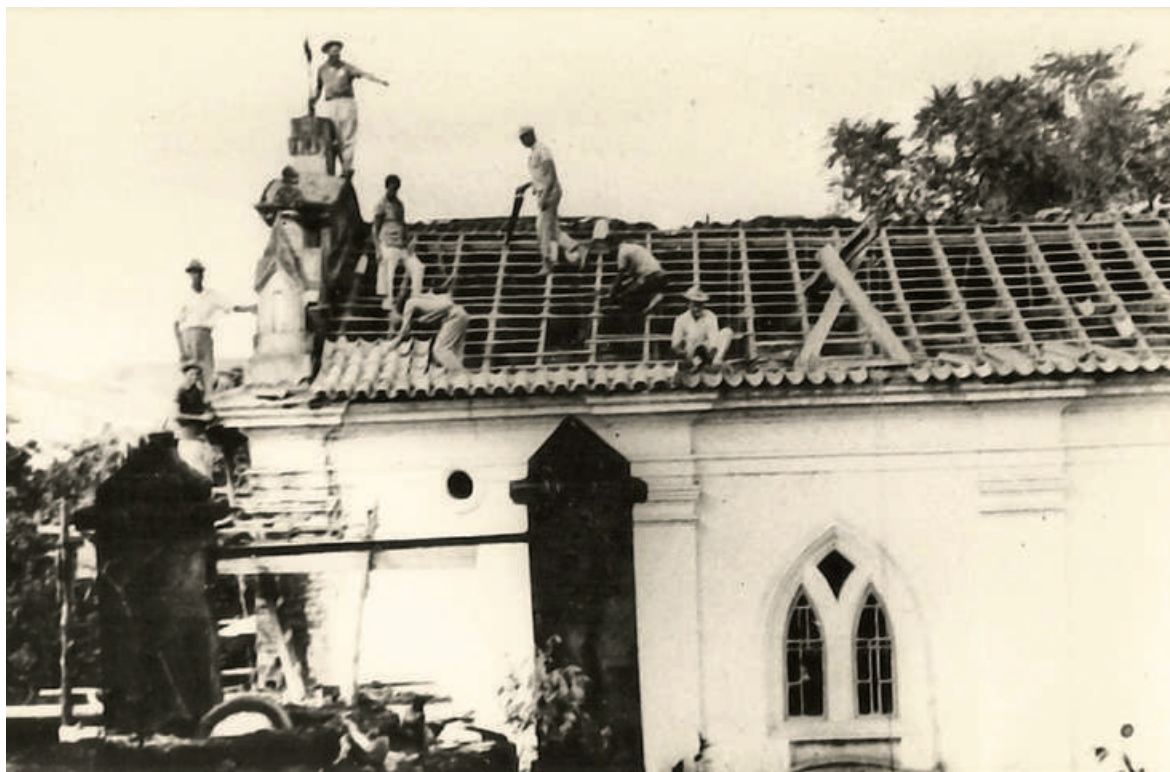
HOMENS TRABALHANDO NO TELHADO DA ERMIDA
