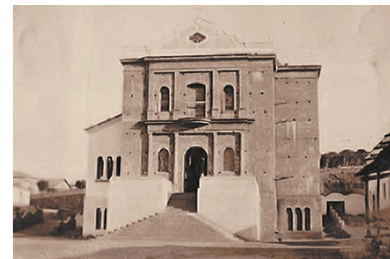
FOTO DA DÉCADA DE 1940, DURANTE A CONSTRUÇÃO DA BASÍLICA
