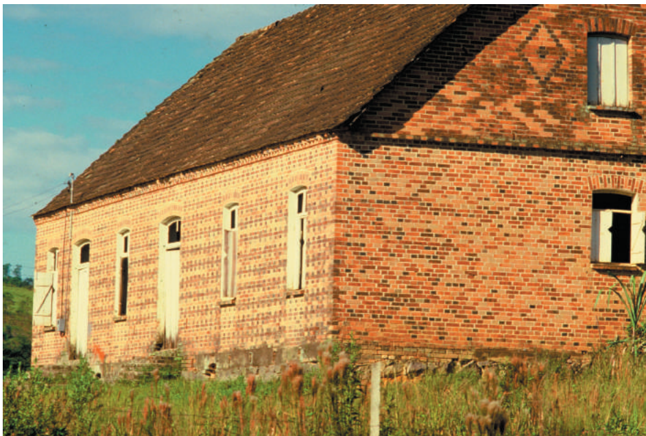
O Salão Hammermeister [TIO013], em Timbó, foi construído especialmente para ser um salão de bailes. Hoje abriga o Museu da Música.
