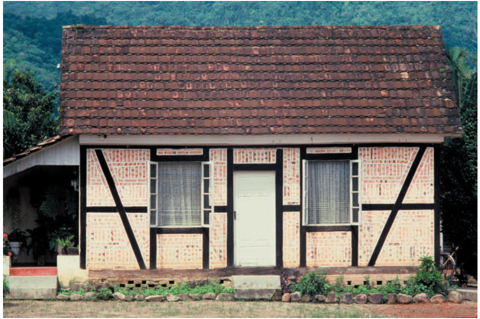
Vista frontal da casa João Carlos Seefeldt [JVE009], em Joinville.
