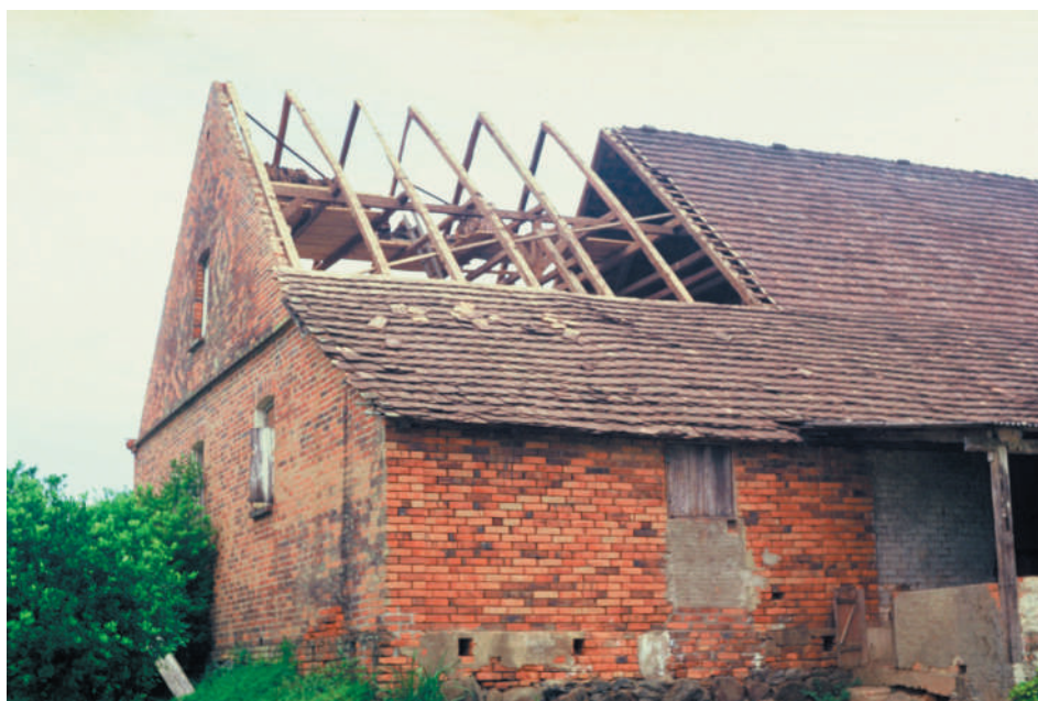
Salão Hammermeister [TIO013] durante a obra de restauração em 1994. A estrutura de caibros do telhado é reforçada por uma linha alta devido às grandes dimensões da edificação.
