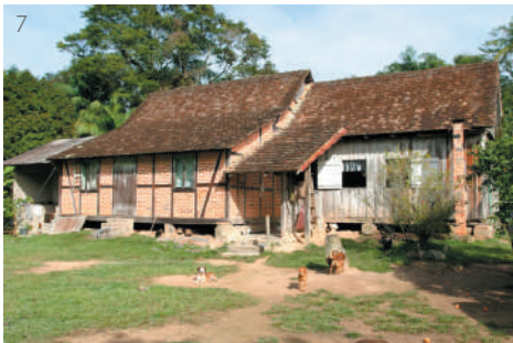
1 - Capela Nossa Senhora do Perpétuo Socorro [IDL113]. Uma verdadeira pérola da arquitetura vernacular, com pinturas decorativas singelas no seu interior (2, 3 e 4) 5 - Casa Luíza Schroeder [IDL050]. Trabalho esmerado na colocação dos tijolos e nos elementos de madeira torneados da varanda. 6 e 7 - Casa Lorival Hersing [IDL039] 8, 9 e 10 - Casa Ristow [IDL035] 11 - Casa Harry Voight [IDL232] 12 - Igreja de Araponguinhas
