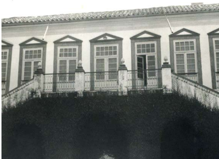
Acesso principal da Fazenda do Castelo, s.a., c.1976 (Acervo INEPAC)
