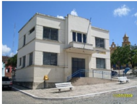
Correios: sua implantação é indício da chegada do progresso nas décadas de 1930/40. Fonte: IPHAEP
