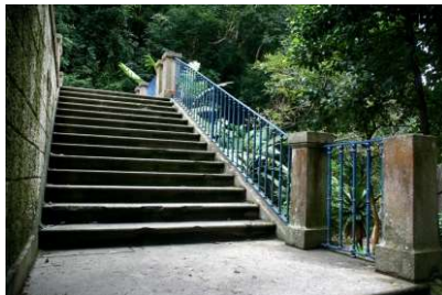
Escada de acesso aos reservatórios
