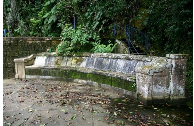
Banco revestido em mármore. 08/2006
