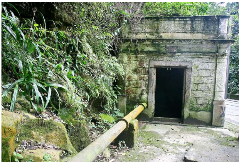
Entrada da Caixa da Mãe D'água. 08/2006.
