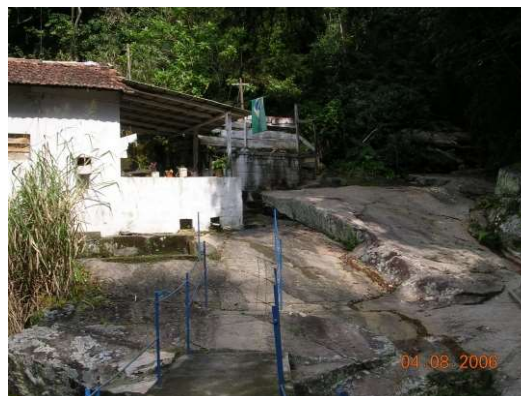
Acréscimo de telhado na casa do encarregado do cloro. 08/2006.
