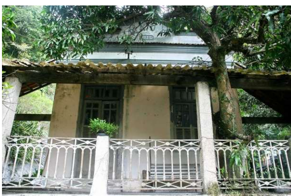
Acréscimo de telhado na casa do encarregado. 08/2006.
