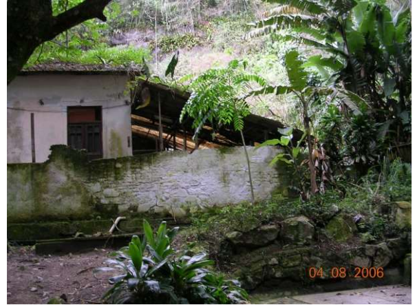
Acréscimo de telhado na casa do encarregado. 08/2006.
