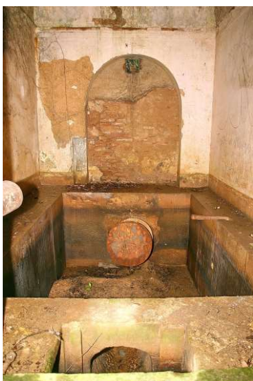
Interior da Caixa da Mãe D'água. 08/2006.
