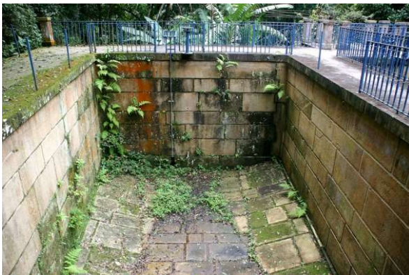
Interior da caixa d'água. 08/2006.
