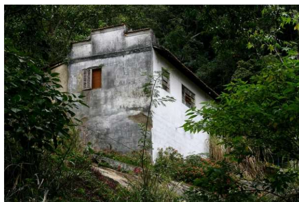
Casa do encarregado do Cloro. 08/2006.
