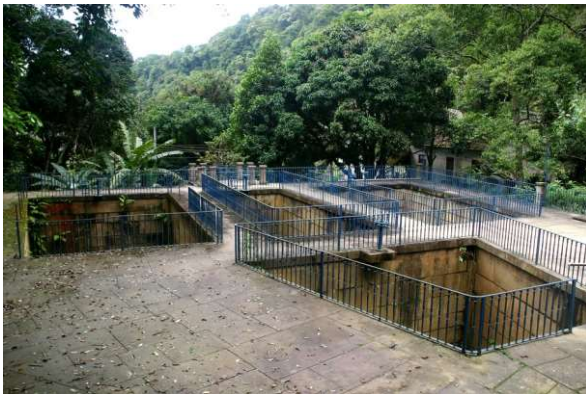
Caixas do Carioca e Decantador. 08/2006.
