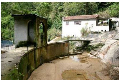
Barragem e casa do encarregado do cloro
