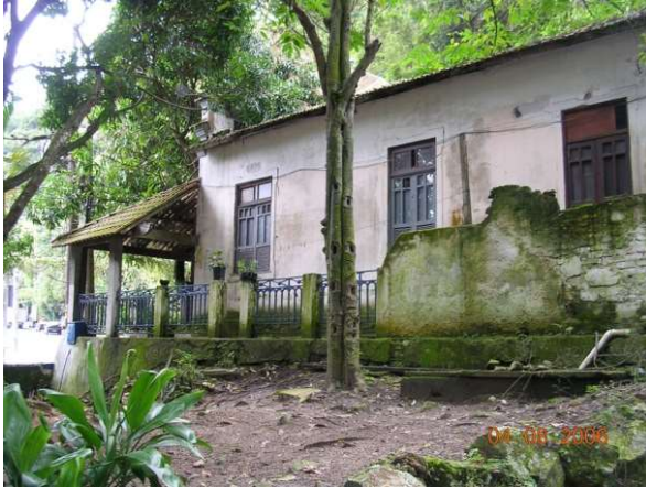
Acréscimo de telhado na casa do encarregado. 08/2006.
