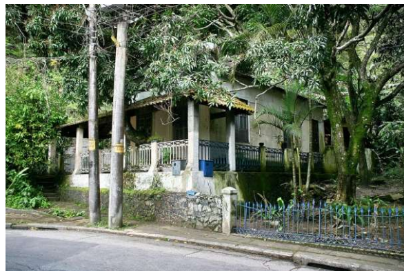
Casa do encarregado das Caixas. 08/2006.
