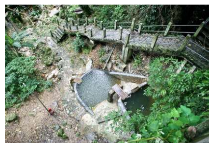
Tanque abaixo da Rua Almt. Alexandrino
