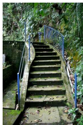
Escada de acesso à barragem
