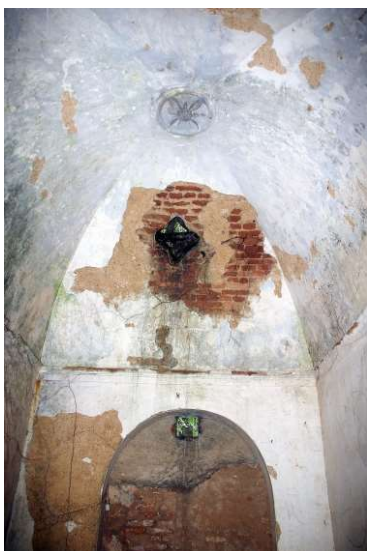
Interior da Caixa da Mãe D'água. 08/2006.
