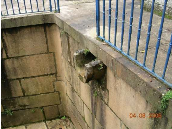
Detalhe da Caixa D'Água. 08/2006
