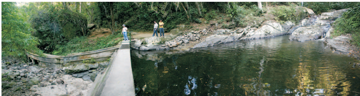
Vista panorâmica da barragem do Rio Grande. Agosto/2006
