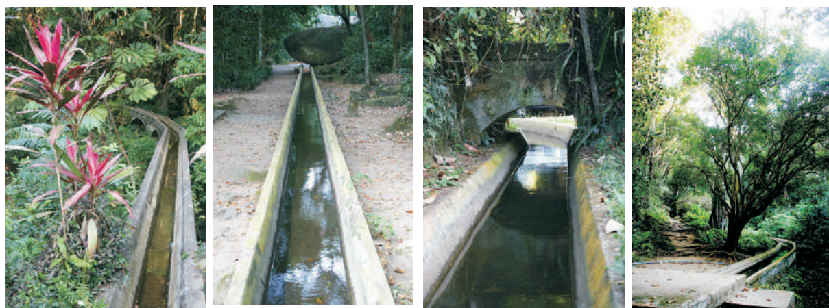
Trechos do aqueduto. Agosto/2006
