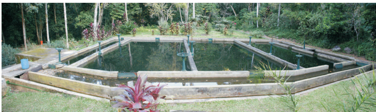
Vista panorâmica das Caixas dos Desarenadores. Agosto/2006
