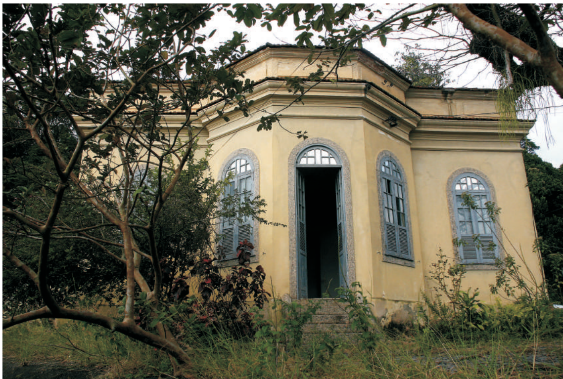
Reservatório do França - residência do encarregado. 08/2006.
