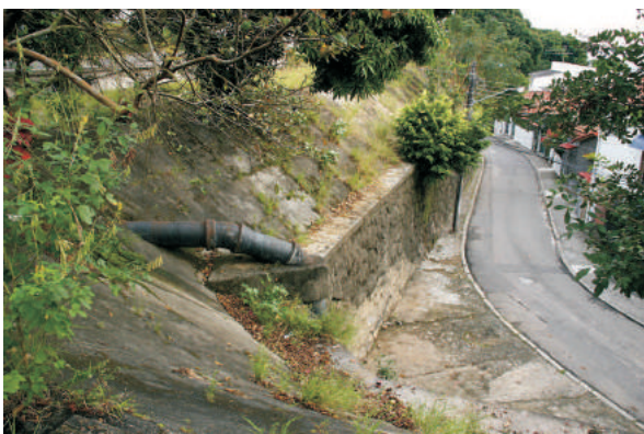
Muro de pedra e talude. 08/2006.
