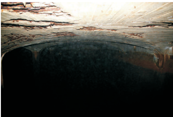
Teto do reservatório. 08/2006.
