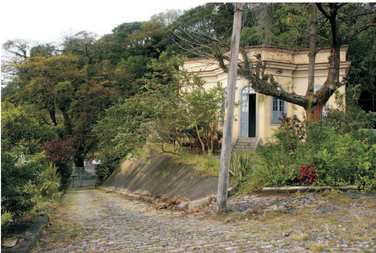
Acesso visto de dentro. 08/2006.
