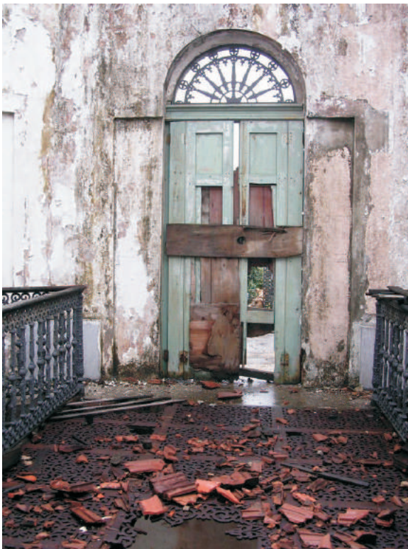
interior do pavilhão de manobras atrás da caixa alta.
