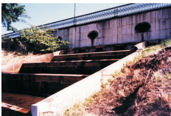
Cascata de aeração - Fotos: Rui Velloso. Maio/1991
