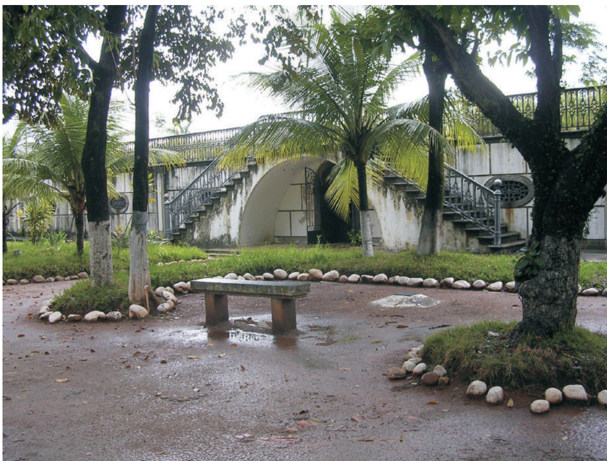
Reservatório de Pedregulho: escada na lateral da caixa alta voltada para a Rua Mal. Jardim. 08/2006.
