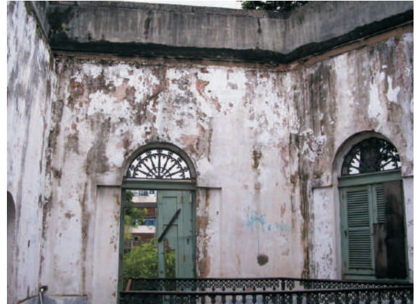
interior do pavilhão de manobras atrás da caixa alta.
