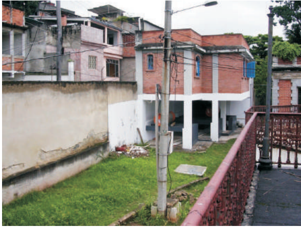
nova construção junto às caixas de passagem
