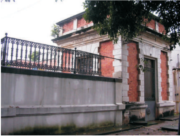
pavilhão de manobra da Quarta Linha Adutora Rio-Xerem
