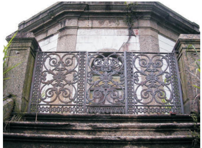
pavilhão de manobras atrás da caixa alta. Julho 2006
