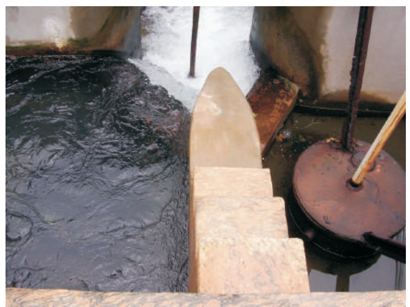
caixa de passagem da água das Adutorasde Rio D'Ouro
