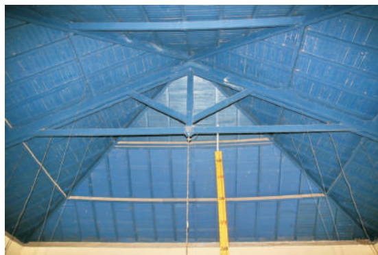
Teto da sala de manobras. 08/2006.
