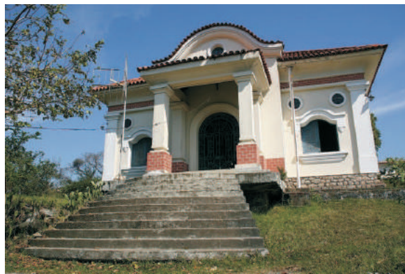
Sala de manobras. 08/2006.
