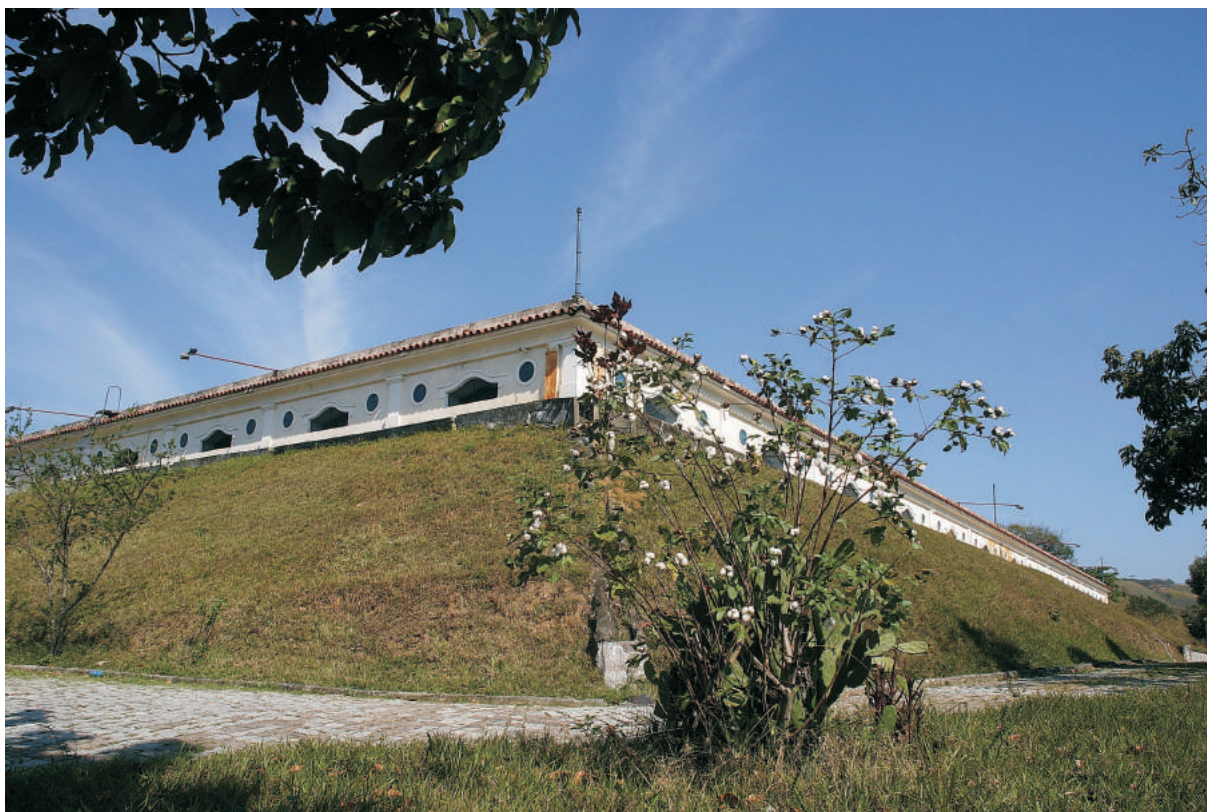
Reservatório Vitor Konder. 08/2006.
