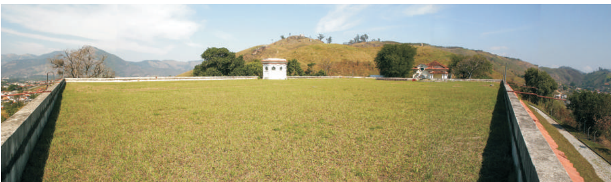
topo do reservatório, posto de visita e casa do encarregado. 08/2006.
