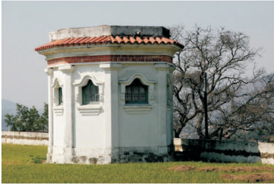
Posto de visita. 08/2006.
