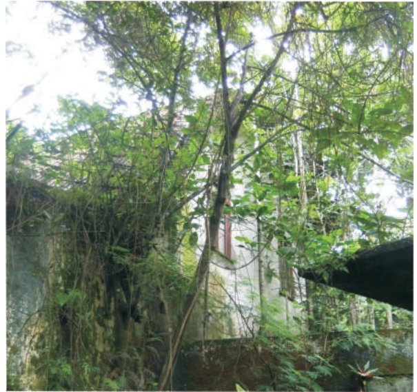
Casa ao lado da Caixa D'Água - 2013
