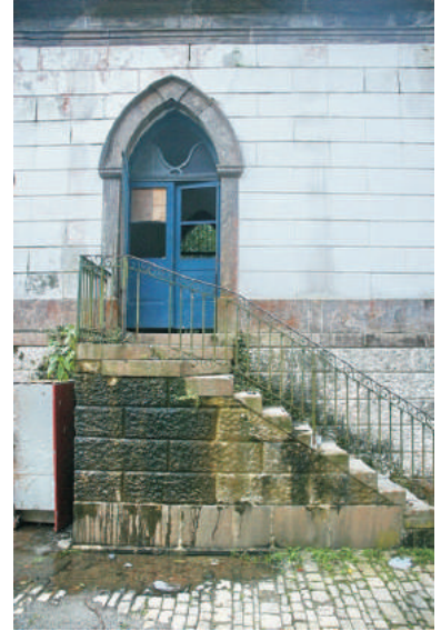
Acesso na fachada dos fundos. 08/2006.
