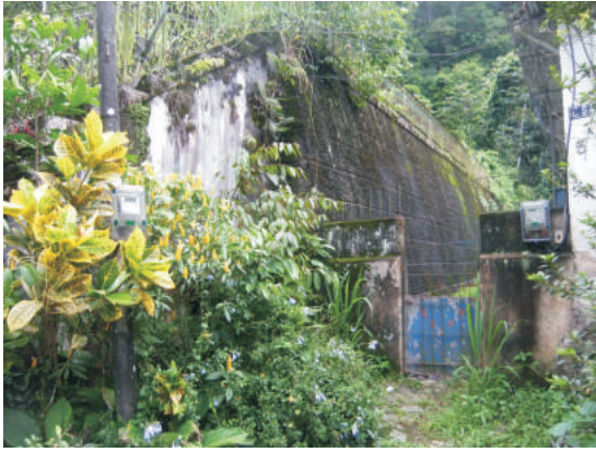
Muro do Açude. 2013.
