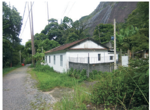
Casa de funcionário no terreno do Reservatório 07/2013.
