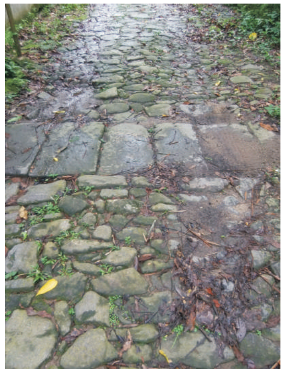
Detalhe da pavimentação do caminho. 07/2013.
