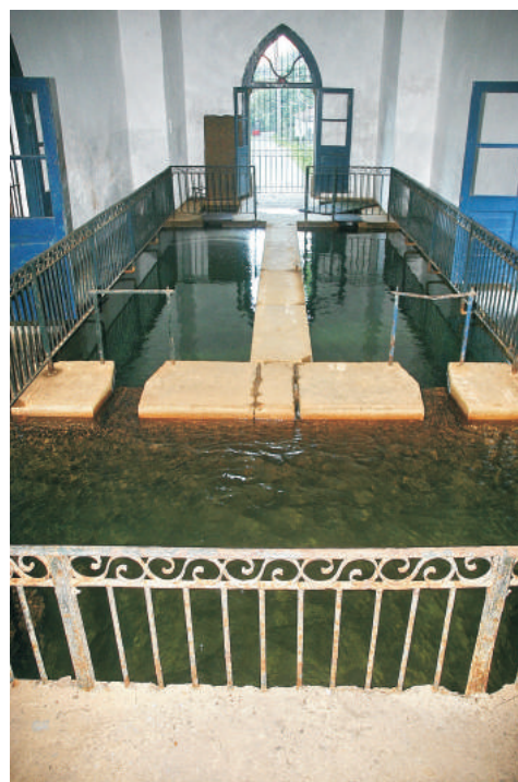
Interior da Caixa Velha, frente. 08/2006.
