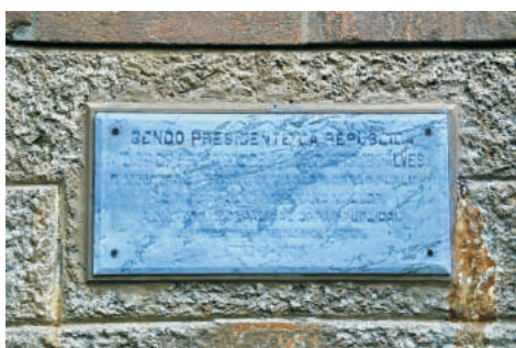
Placa de instalação dos contadores Venturi.
