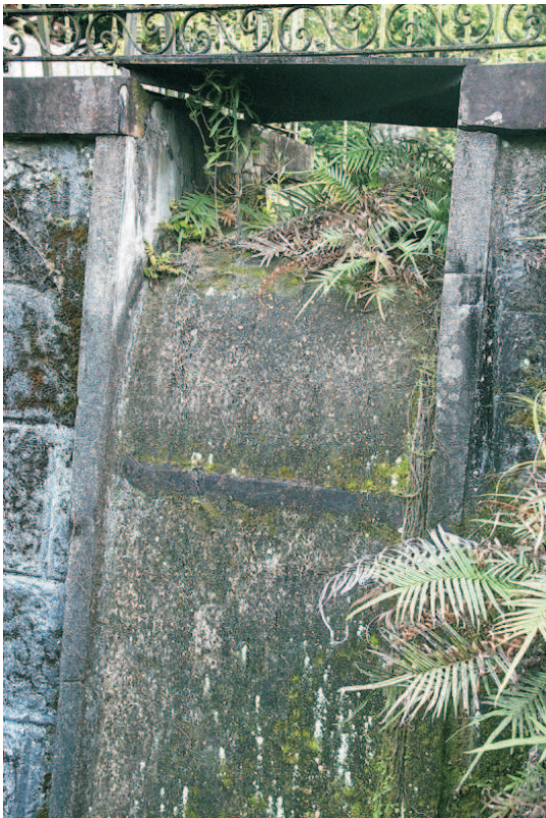
Detalhe do ladrão. 08/2006.
