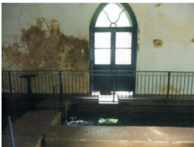
Interior da Caixa D'Água. 07/2013.
