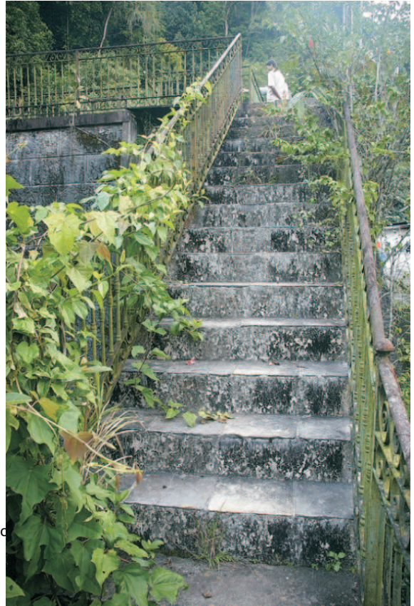
Escada de acesso ao Açude. 08/2006.
