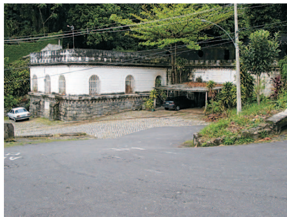
Casa de manobra e reservatório ao fundo, 08/2006.
