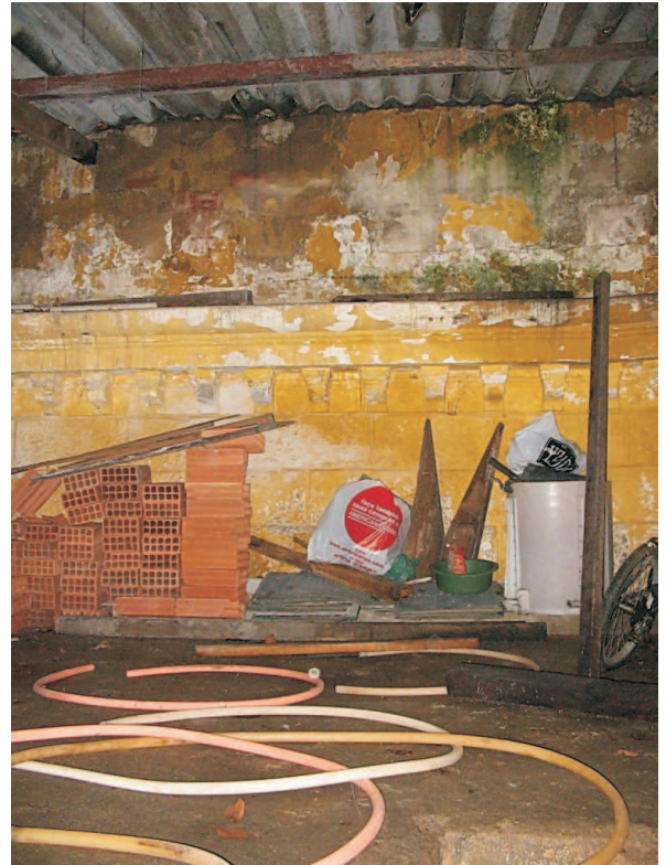
Obras junto ao muro do reservatório. 08/2006.
