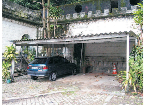
Telheiro para a guarda de veículos. 08/2006.
