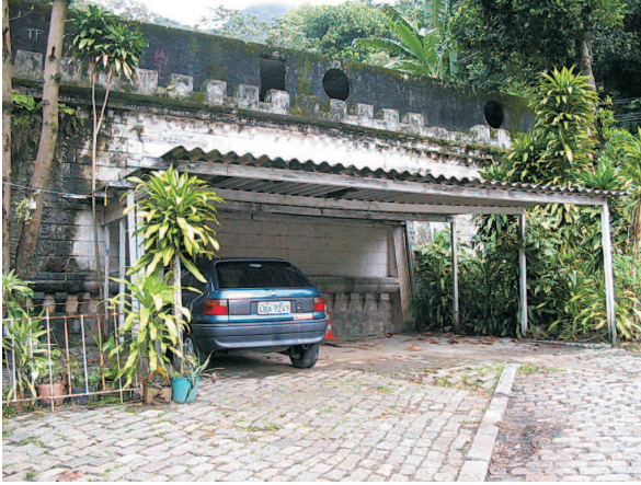
Telheiro para a guarda de veículos. 08/2006.
