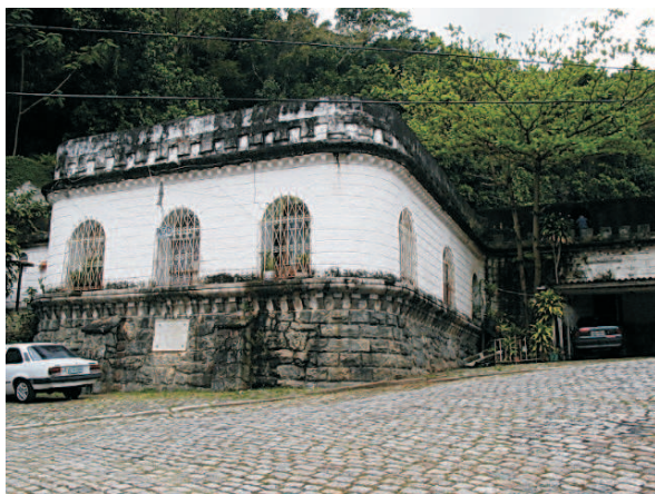
Casa de manobra e reservatório ao fundo, 08/2006.
