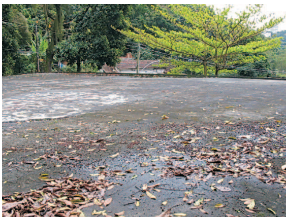
Laje de cobertura. 08/2006
