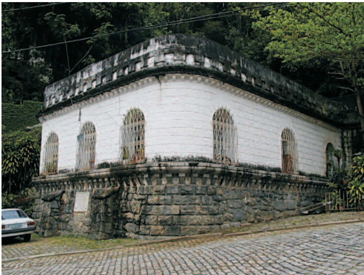
Reservatório do Morro do Inglês - Casa de Manobra, 08/2006.
