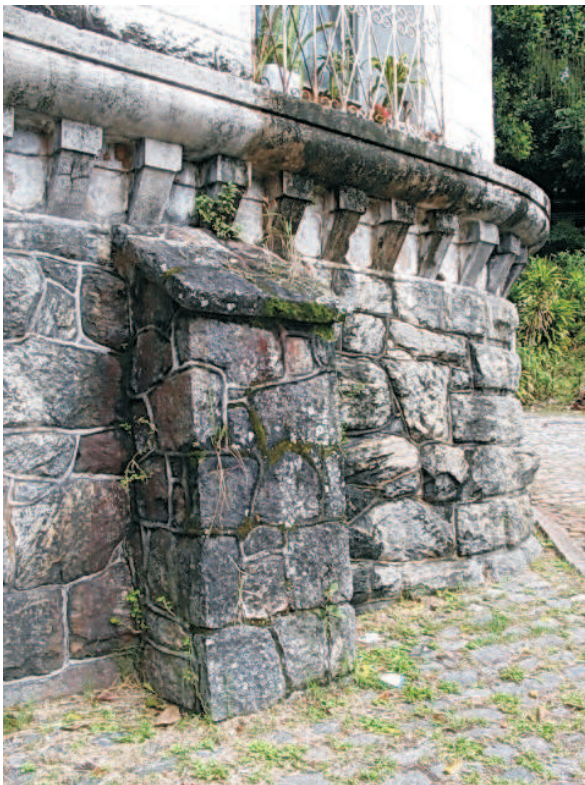
Detalhe do embasamento. 08/2006.
