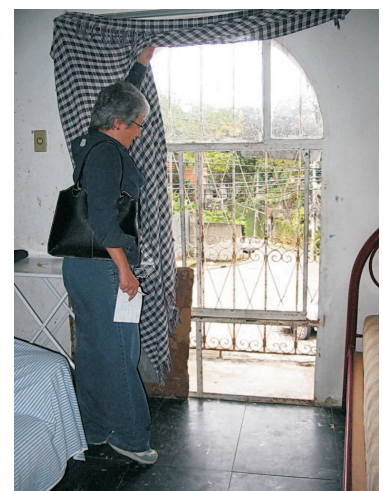
Janela vista do interior. 08/2006.
