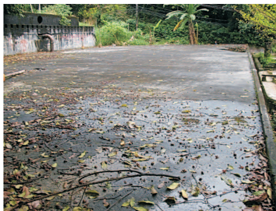
Laje de cobertura. 08/2006
