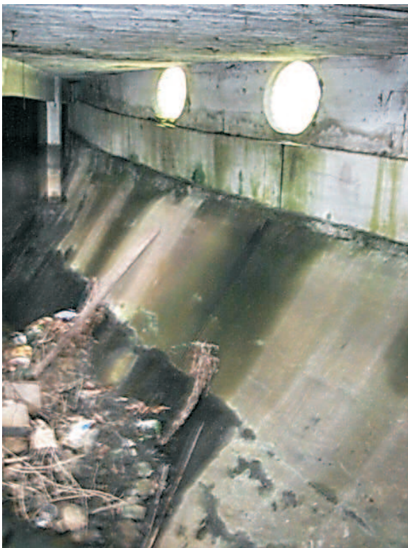
Interior do reservatório. 08/2006.
