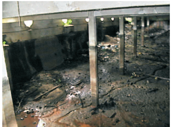
Interior do reservatório. 08/2006.
