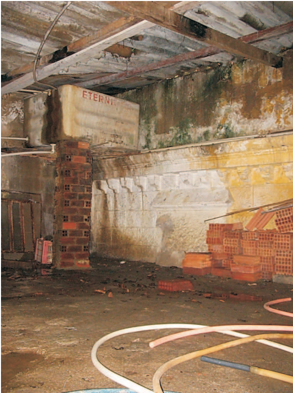
Obras junto ao muro do reservatório. 08/2006.
