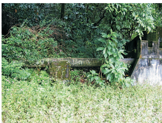
Adução do reservatório. 08/2006
