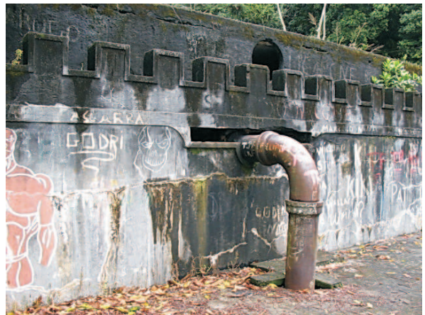
Muro do reservatório mais alto. 08/2006.
