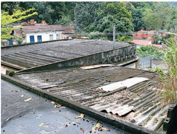
Telhado da casa de manobra e do acréscimo. 08/2006.
